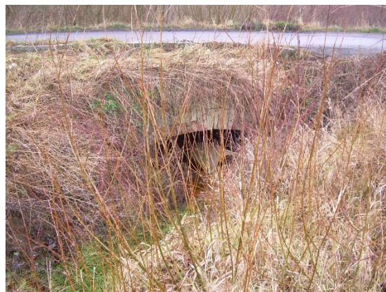
Obrázek 10 – Zděný propustek 2007, zdroj: archiv SVSMP
