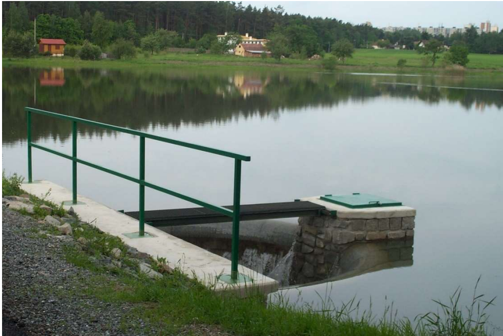
Obrázek 13 - Přelivný objekt rybníka Košináře za zvýšeného vodního stavu, zdroj: archiv SVSMP
