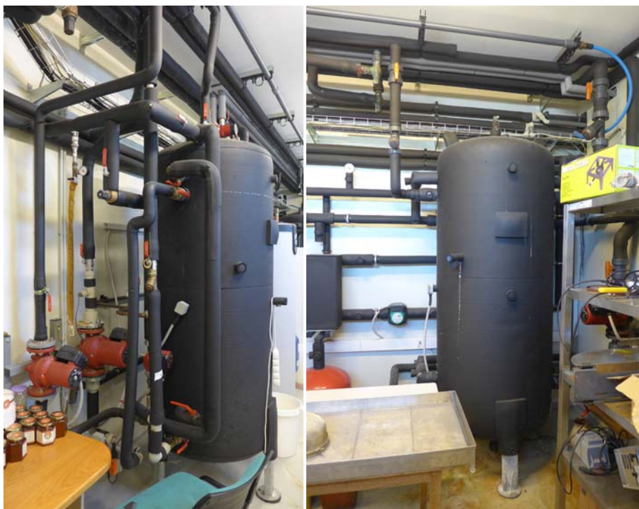
Obr.32: Akumulační nádrže - vlevo AKU teplo, vpravo AKU chlad [foceno: 26.7.2019, Vinařství Šlechtitelka, Velké Pavlovice]
