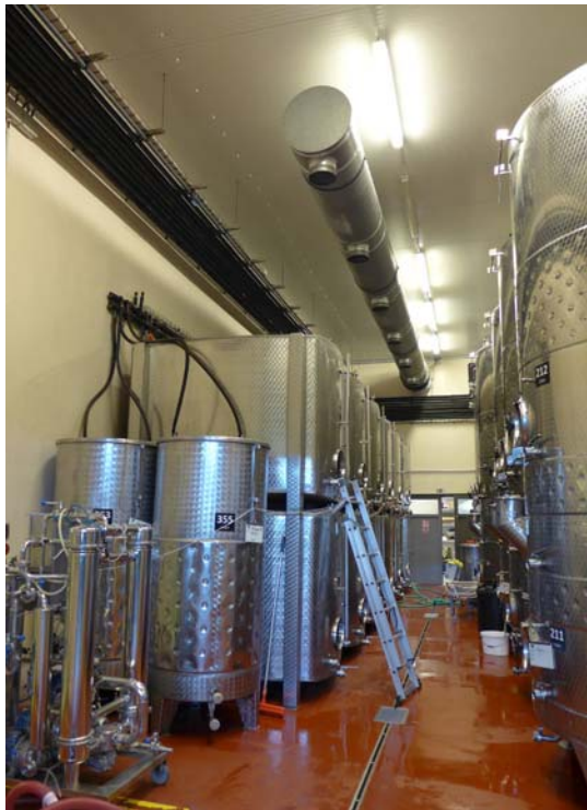
Obr.27: přívodní potrubí VZT v místnosti „Zrání – bílé víno“ [foceno:26.7.2019, Vinařství Šlechtitelka, Velké Pavlovice]
