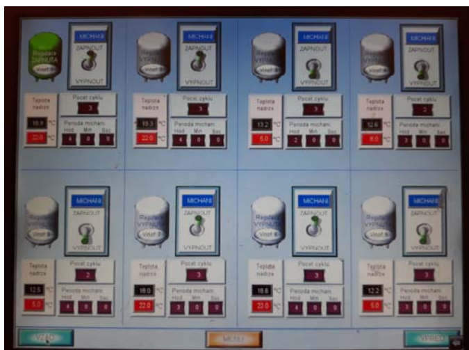
Obr.11: Řídicí obrazovka – ovládání vinifikátorů [foceno: 26.9.2019, Vinařství Šlechtitelka, Velké Pavlovice]
