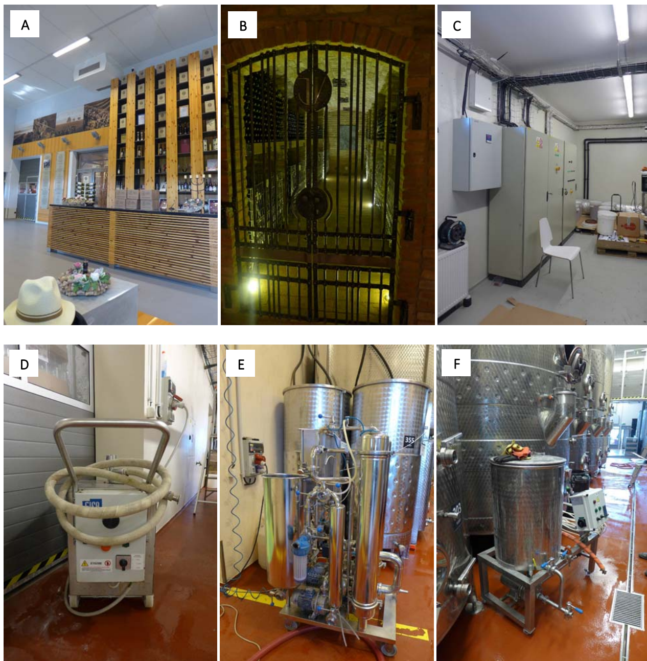
Obr.15: A – vstupní hala, B – archivní sklepy-penzion André, C – elektroskříně, D – mobilní vyvíječ páry, E – flotační přístroj, F – mobilní Cip stanice [foceno: 26.7.2019, Vinařství Šlechtitelka, Velké Pavlovice]
