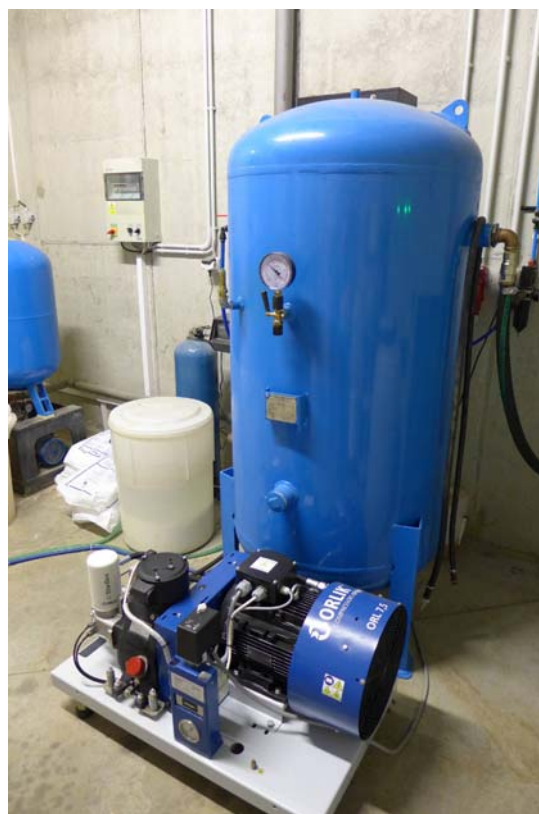
Obr. 61: Vinařství Sonberk – technická místnost, vlevo zdroj chladu tepelné čerpadlo země – voda, vpravo kompresor na výrobu stlačeného vzduchu [foceno: 29.11.2019, Vinařství Sonberk, Popice]
