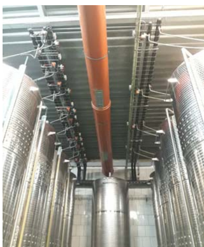
Obr.46: Napojení tanku s duplikátorovým pláštěm na rozvod chladicího a ohřivacího média [foceno: 11.10.2019, Vinařství ANNOVINO, Lednice]
