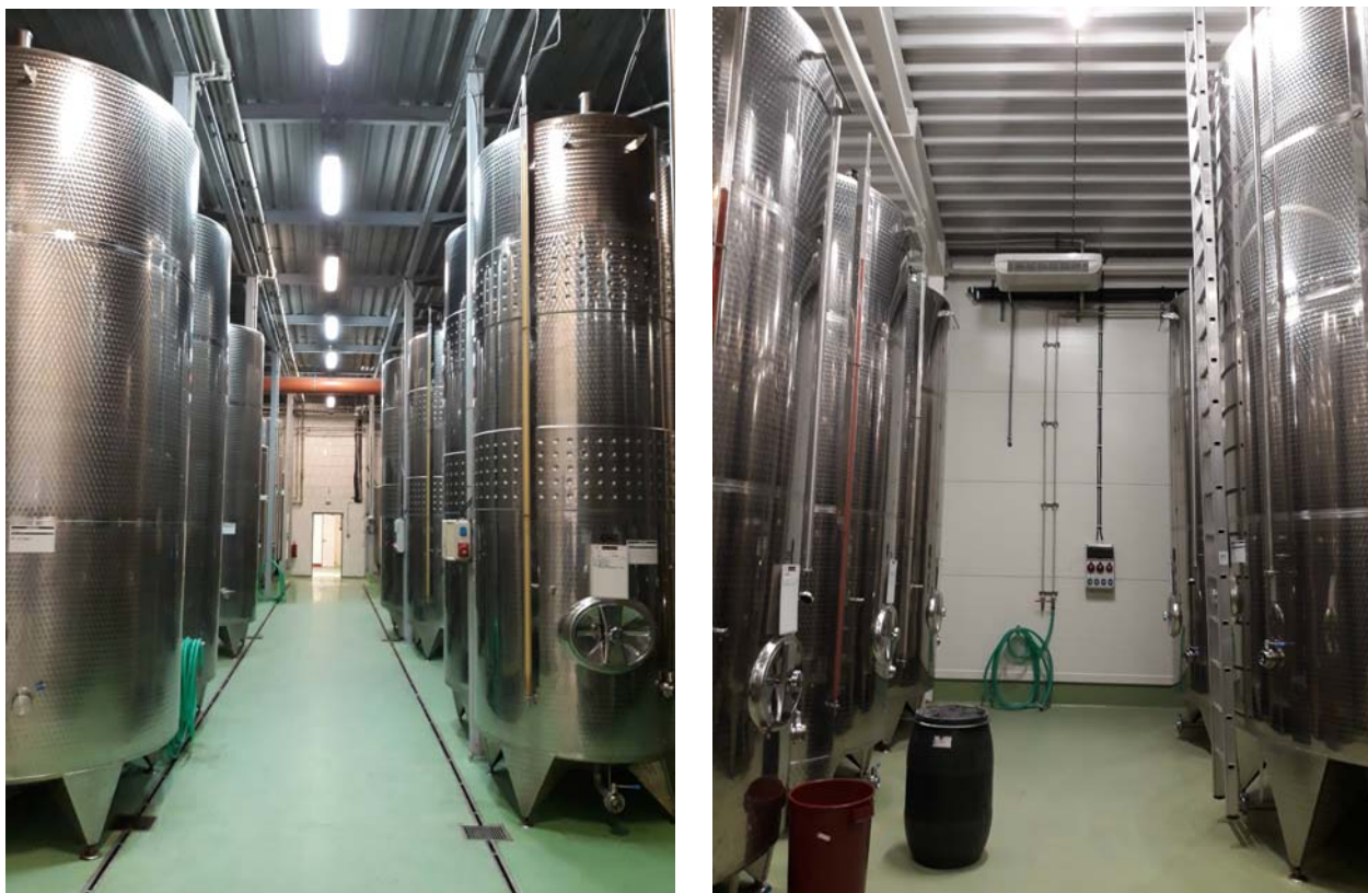
Obr.42: Vlevo tanková hala 1 „Kvasná místnost“, vpravo tanková hala 2 „Ležácká místnost“ [foceno: 11.10.2019, Vinařství ANNOVINO, Lednice]
