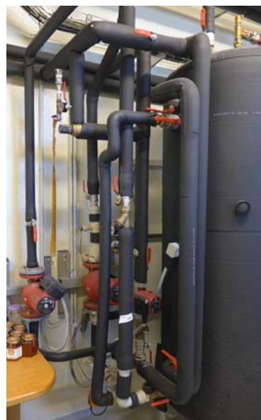
Obr. 25: Vlevo Schéma napojení AKU tepla na otopný systém administrativní části [poskytnutá dokumentace k vinařství], vpravo skutečné provedení napojení [foceno: 26.7.2019, Vinařství Šlechtitelka, Velké Pavlovice]
