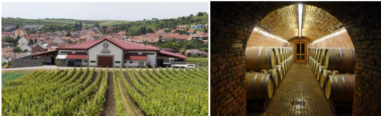
Obr. 5: Vlevo pohled na výrobní halu [15], vpravo sklepní prostory v Penzionu André [foceno: 26.7.2019, Vinařství Šlechtitelka, Velké Pavlovice]
