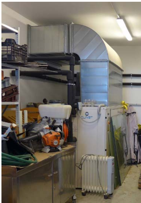
Obr.35: Vlevo chladič Clivet WRA 142, vpravo protidešťová žaluzie [foceno: 26.7.2019, Vinařství Šlechtitelka, Velké Pavlovice]
