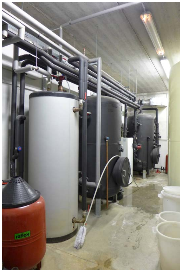
Obr. 61: Vinařství Sonberk – technická místnost, vlevo zdroj chladu tepelné čerpadlo země – voda, vpravo kompresor na výrobu stlačeného vzduchu [foceno: 29.11.2019, Vinařství Sonberk, Popice]
