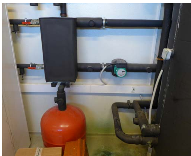
Obr.31: Výměník mezi primárním okruhem a sekundárním okruhem [foceno: 26.7.2019, Vinařství Šlechtitelka, Velké Pavlovice]
