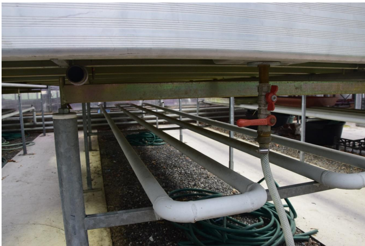
Obr. 9 Detail fotografie interiéru skleníku (topný okruh pod kořínky rostlin)
