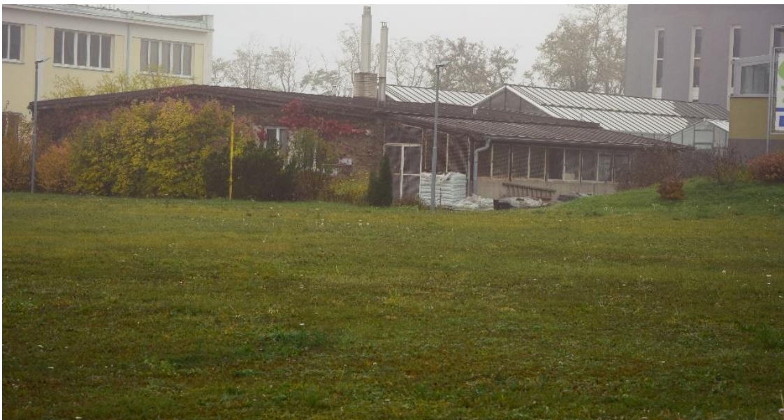
Obr. 4 Fotografie stávajícího stavu řešeného objektu
