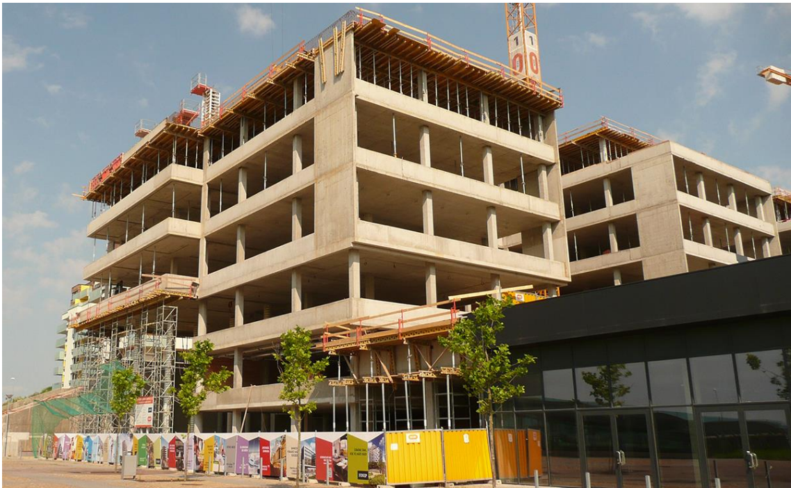
Obr. 5.7 Fotografie z realizace objektu [22]
