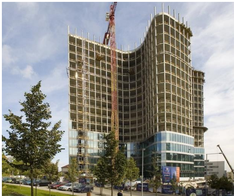
Obr. 2.4 Příklad skeletového konstrukčního systému [26]
