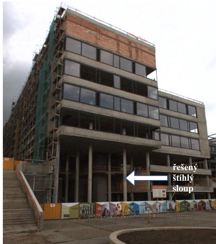
Obr. 5.9 Štíhlé sloupy v místě vstupu do objektu [29]
