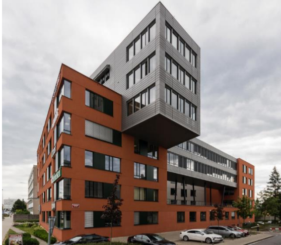
Obr.2.2. East Building v pražské Krči. (zdroj: [16])
