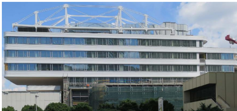
Obr.2.4. Budova Trimaran na pražské Pankráci (zdroj: [19])
