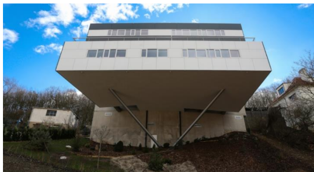
Obr.3.1. Pohled na vykonzolovanou část objektu. (zdroj: [4])
