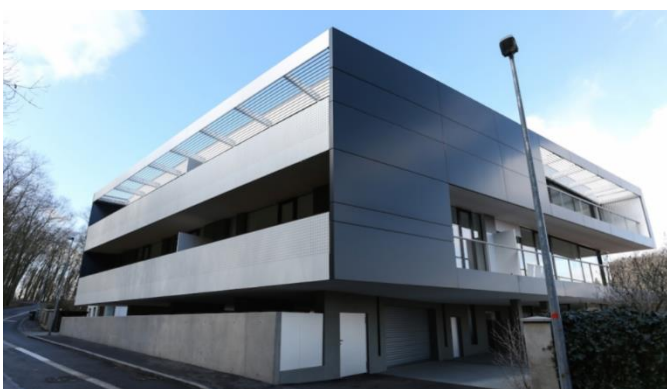
Obr.3.3. Pohled na vchodovou část objektu z ulice Pod Kesnerkou (zdroj: [4])
