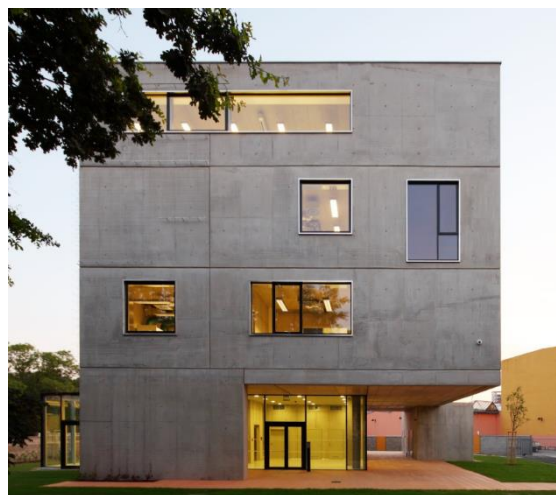
Obr.2.1. Budova počítačového centra CzechGlobe.(zdroj: [20])
