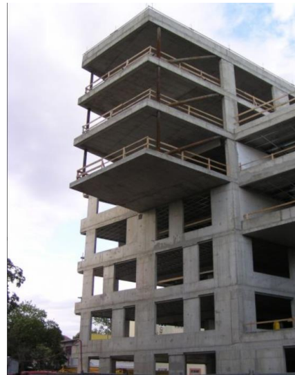
Obr.2.3. Nosná konstrukce East Building. (zdroj: [18])
