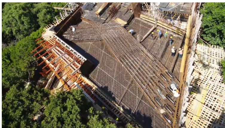
Obr. 2.29: Issam Fares Institute – výstavba [17]
