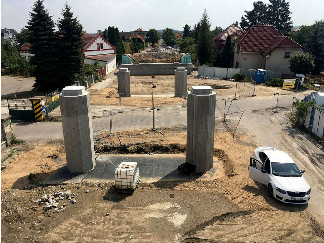
Obrázek 2 Spodní stavba - most Lysá nad Labem [4]
