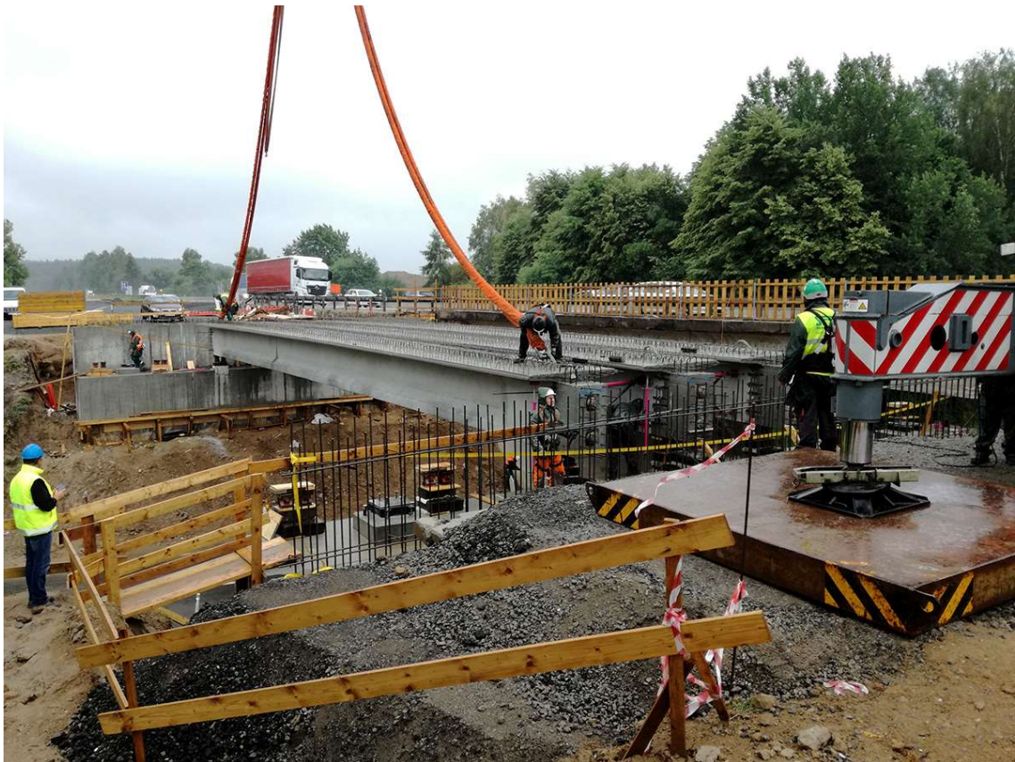
Obrázek 3 Nosná konstrukce - most D1 – Soutice [5]
