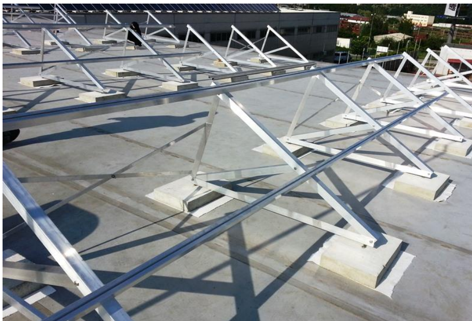
Obrázek č. 29: Alu konstrukce upevnění pro ploché střechy. [21]
