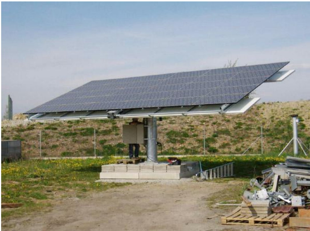
Obrázek č. 31: Konstrukce polohovacích systémů. [23]
