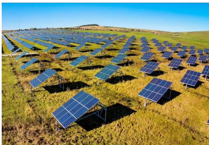
Obrázek č. 30: Konstrukce upevnění pro volná prostranství. [23]
