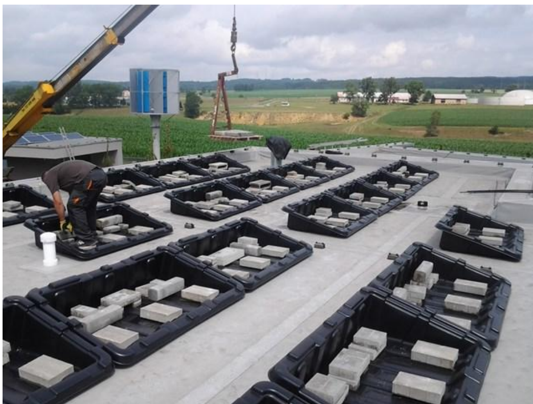
Obrázek č. 28: Konstrukce upevnění pro ploché střechy. [21]
