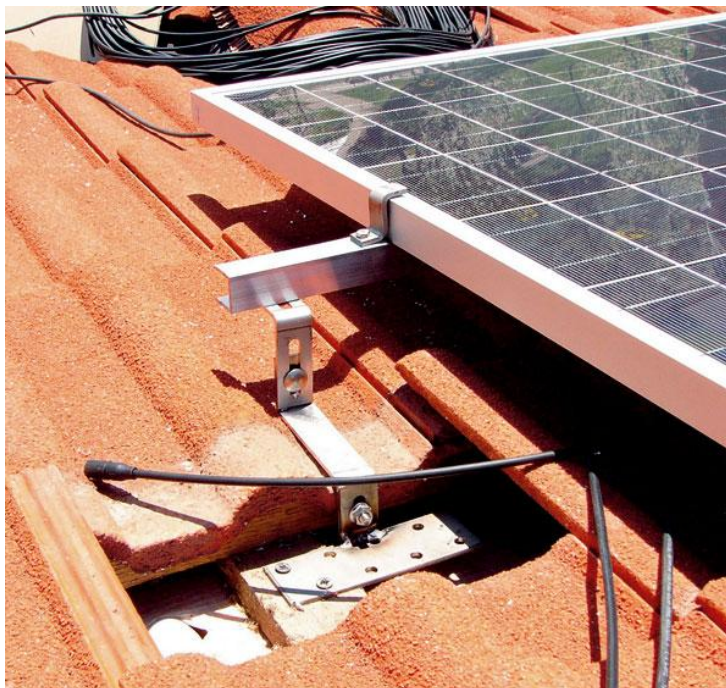
Obrázek č. 27: Konstrukce upevnění pro sedlové střechy. [21]
