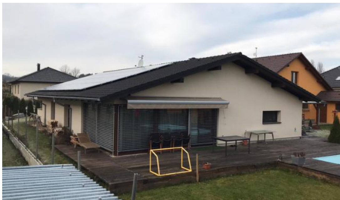
Obrázek č. 51: Pohled na rodinný dům po instalaci FVE (vlastní zpracování)
