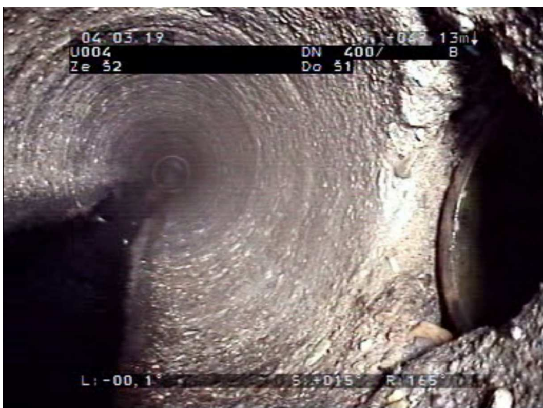
Obrázek č. 35: Utopená přípojka v úseku Š2 – Š1 [Zepris s.r.o.]
