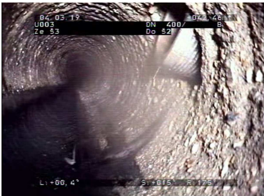
Obrázek č. 34: Přesazená přípojka v úseku Š3 – Š2 [Zepris s.r.o.]
