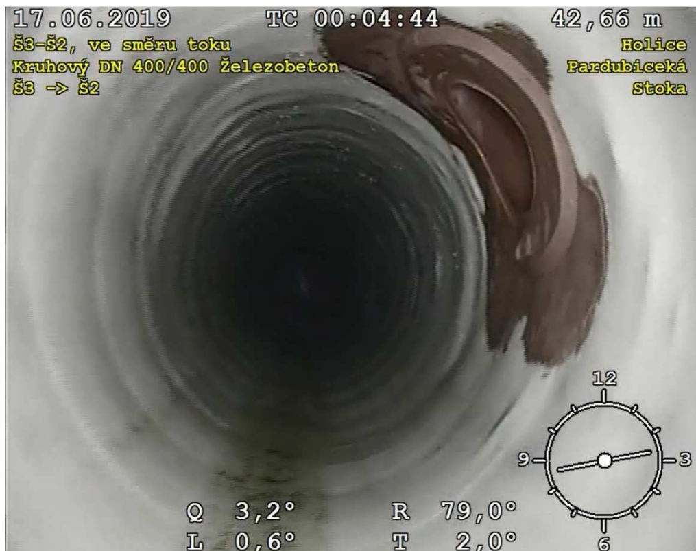
Obrázek č. 44: Přesazená přípojka po injektáži ZEP-RE-CON [Zepris s.r.o.]
