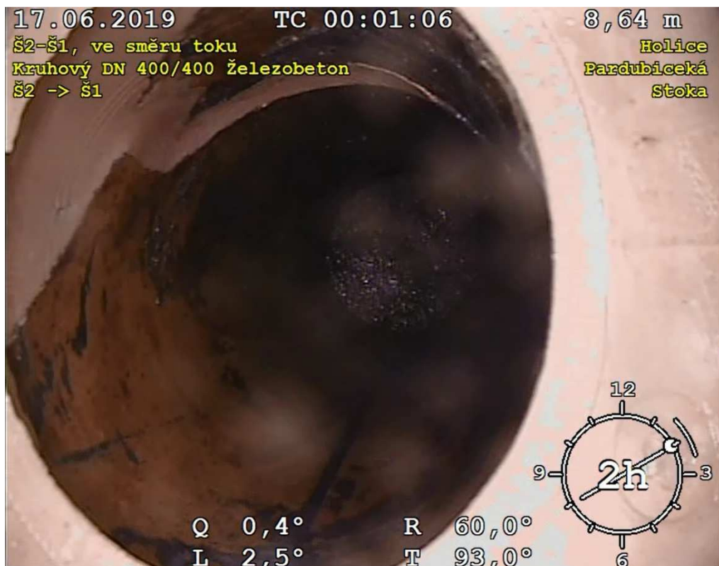
Obrázek č. 46: Přípojka po odstranění žulové kostky a injektáži [Zepris s.r.o.]
