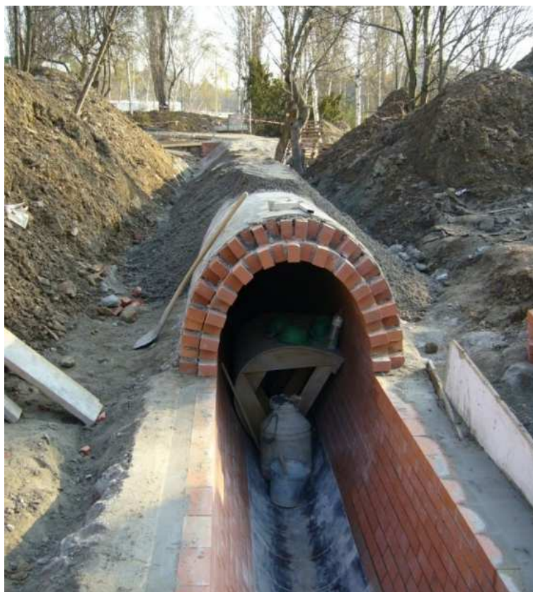
Obrázek č. 16: Zděná kanalizace [15]
