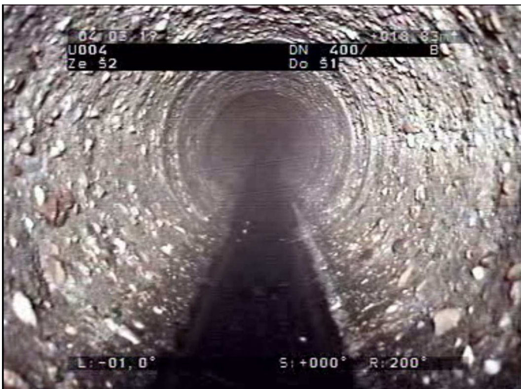
Obrázek č. 33: Stávající betonové potrubí [Zepris s.r.o.]
