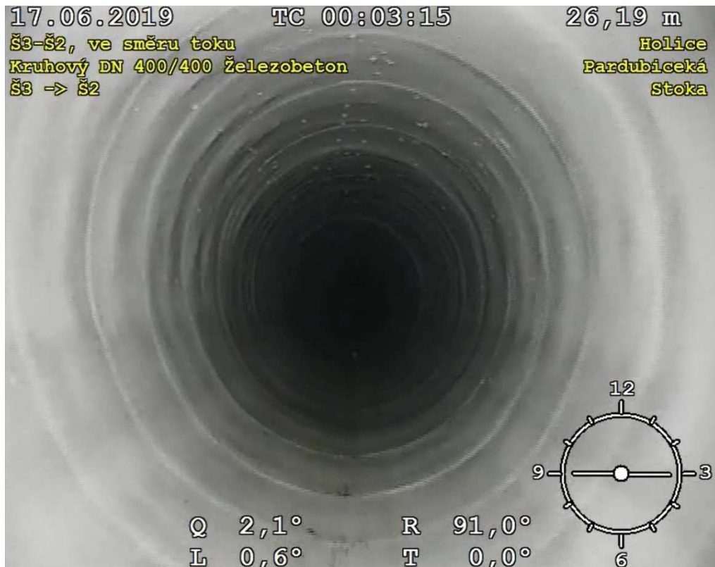
Obrázek č. 43: Potrubí po sanaci rukávem GFK-Liner [Zepris s.r.o.]
