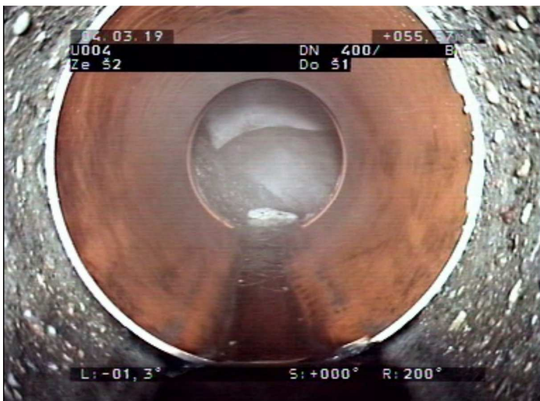
Obrázek č. 39: Vložka z plastové trouby DN 400 1 m před Š5 [Zepris s.r.o.]
