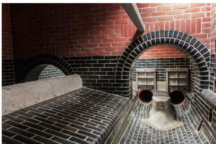
Obrázek č. 15: Obezdívka čedičovými a kanalizačními cihlami [14]
