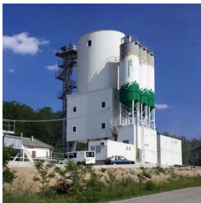
Obrázek 22 - stacionární betonárna s věžovým zásobníkem na kamenivo [28]
