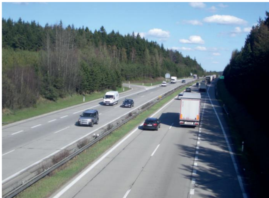
Obrázek 10 - Úsek zakázky A před modernizací
