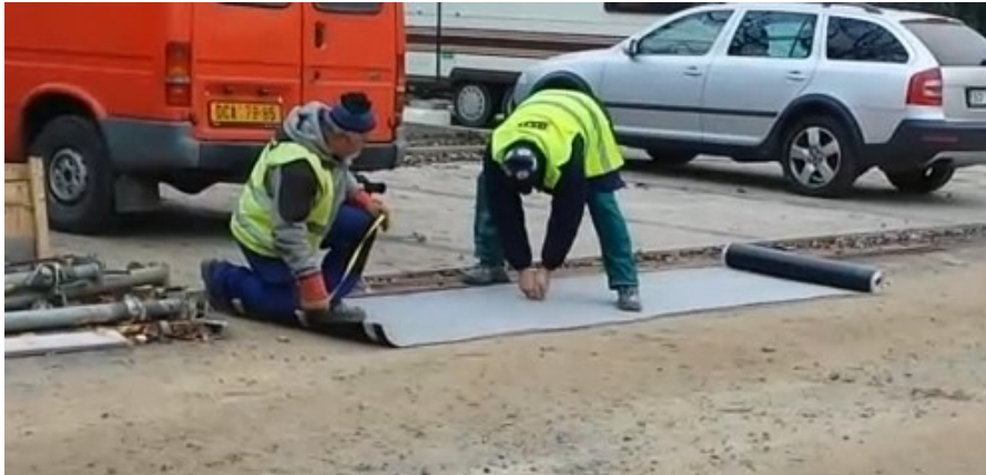
Obrázek 31: Řezání asf. pásů [vlastní]
