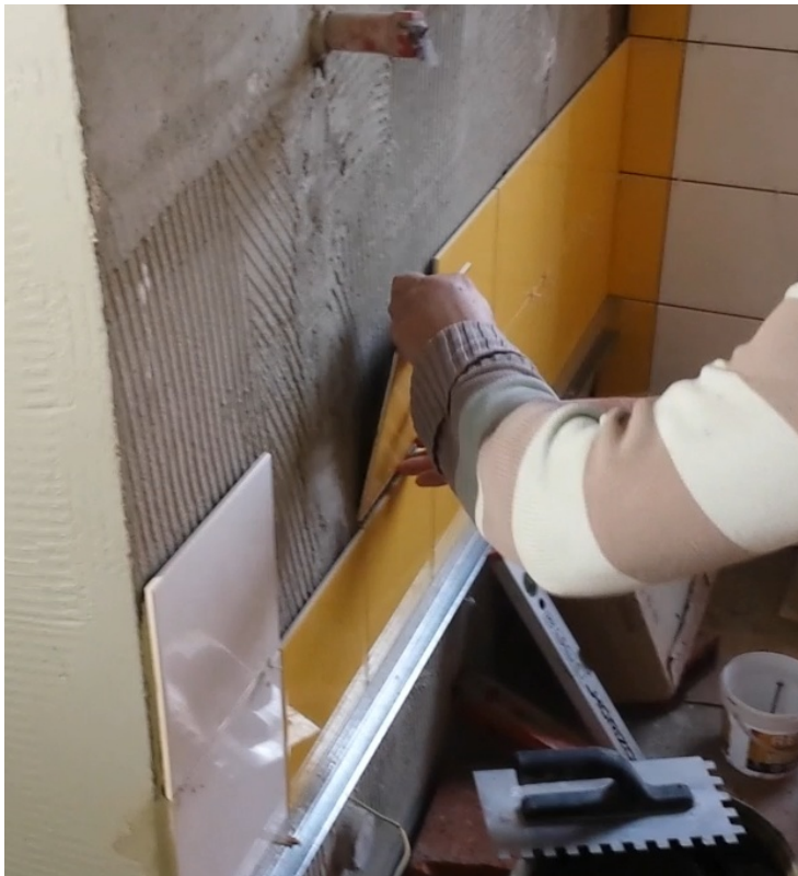
Obrázek 9: Montáž obkladu [vlastní]
