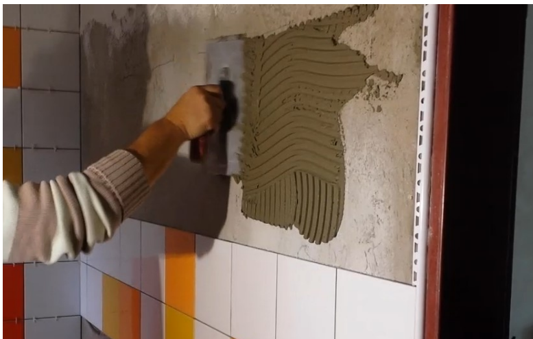
Obrázek 15: Nanášení lepidla [vlastní]
