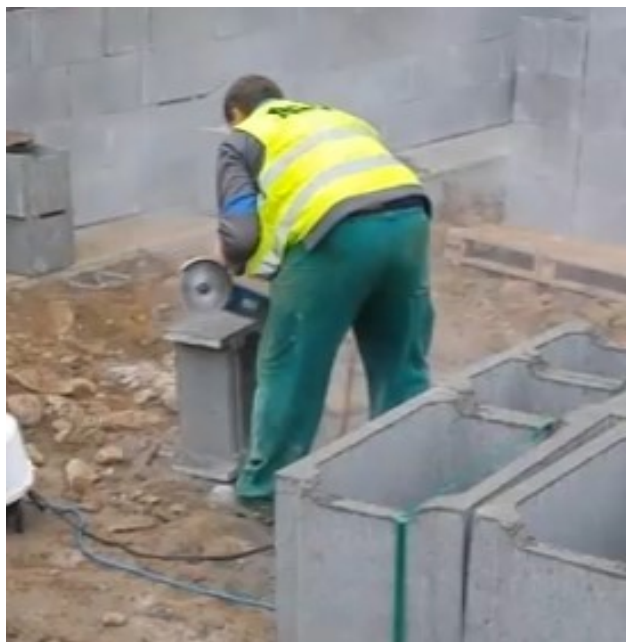
Obrázek 25: Řezání tvárnice [vlastní]
