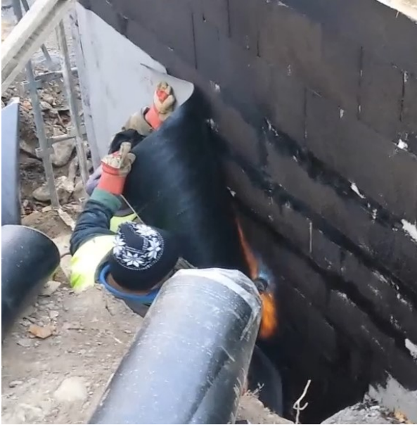
Obrázek 32: Natavení asf. pásu [vlastní]
