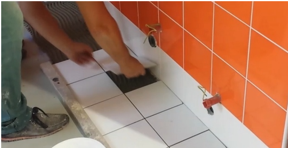
Obrázek 20: Montáž dlažby [vlastní]
