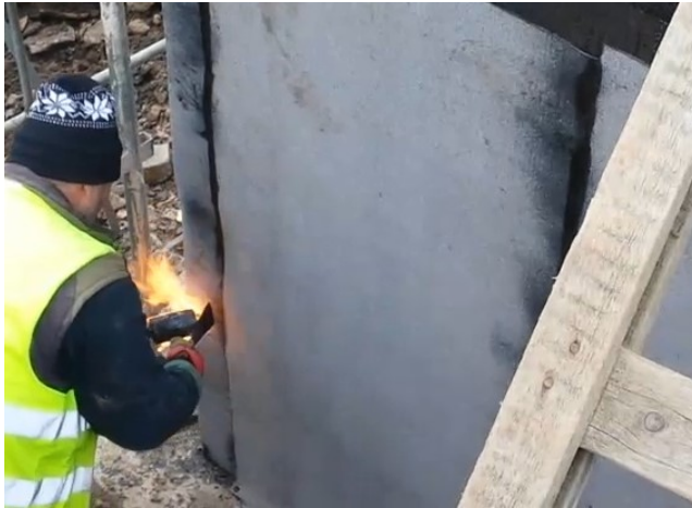
Obrázek 33: Dokončení spojů [vlastní]
