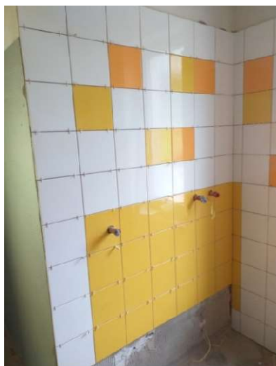
Obrázek 8: Hotový nerovný povrch [vlastní]
