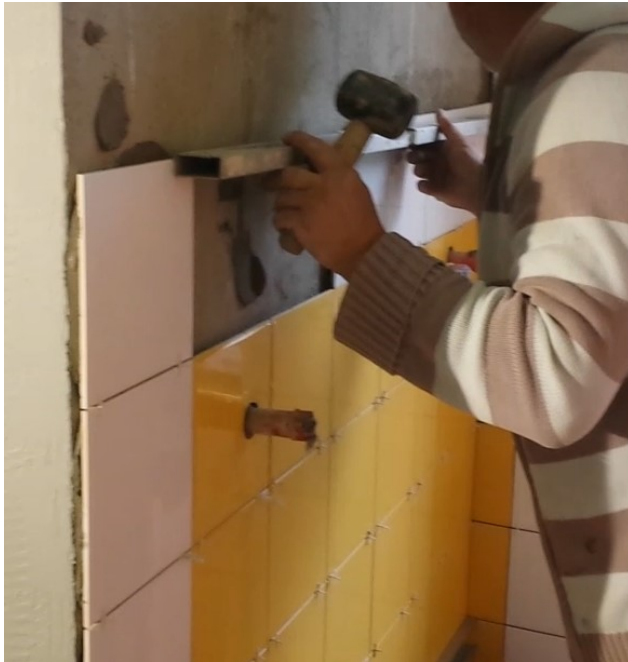
Obrázek 10: Kontrola rovinnosti vodováhou [vlastní]
