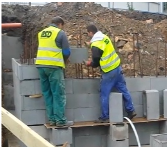
Obrázek 24: Umístění tvárnic [vlastní]
