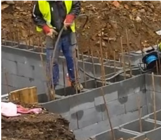
Obrázek 27: Vibrování betonu [vlastní]
