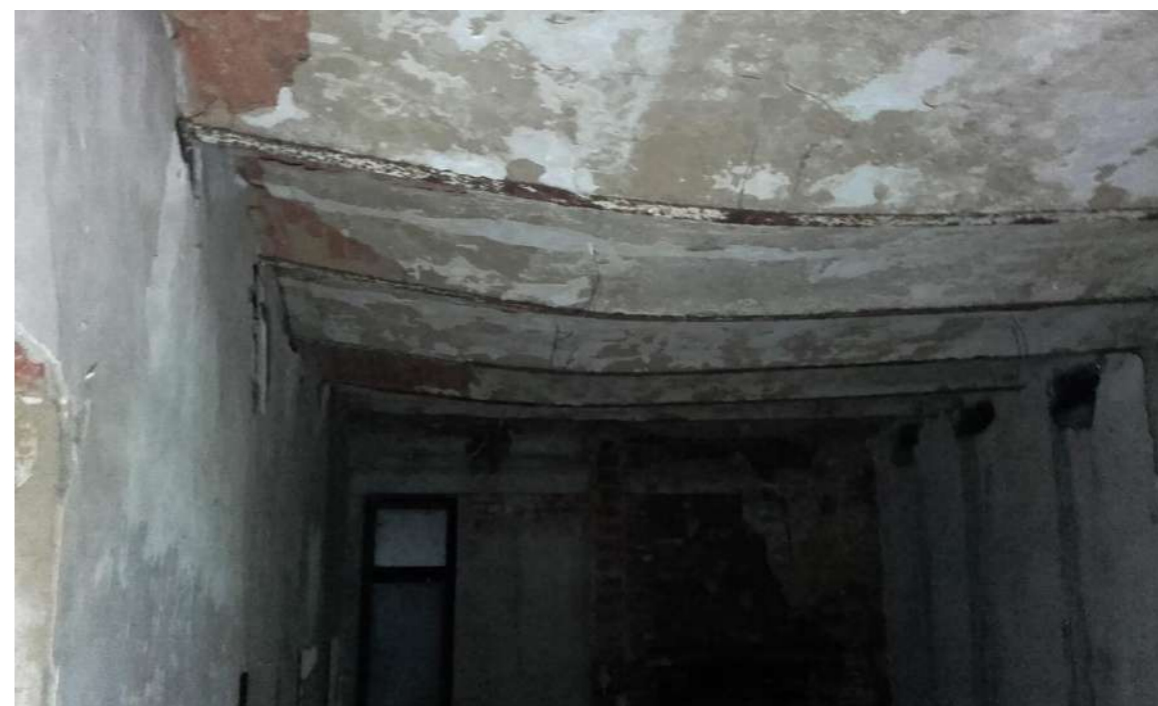
Obrázek 5: Průhyb stropu pod sálem [2]
