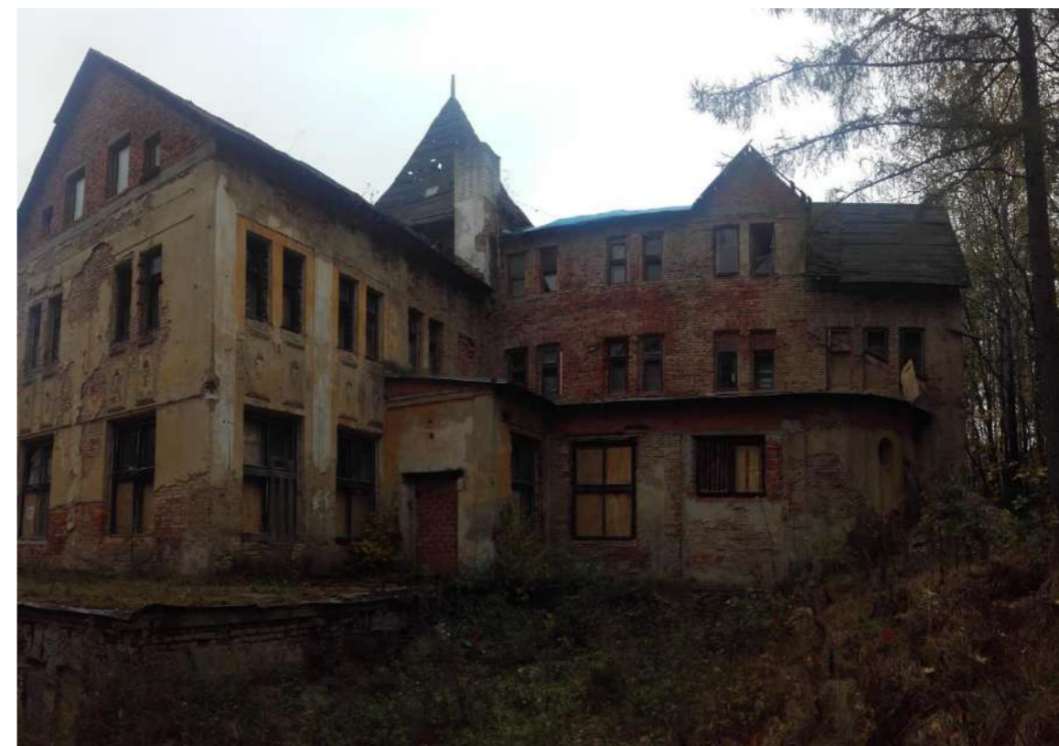
Obrázek 4: Současný stav obvodových konstrukcí [2]
