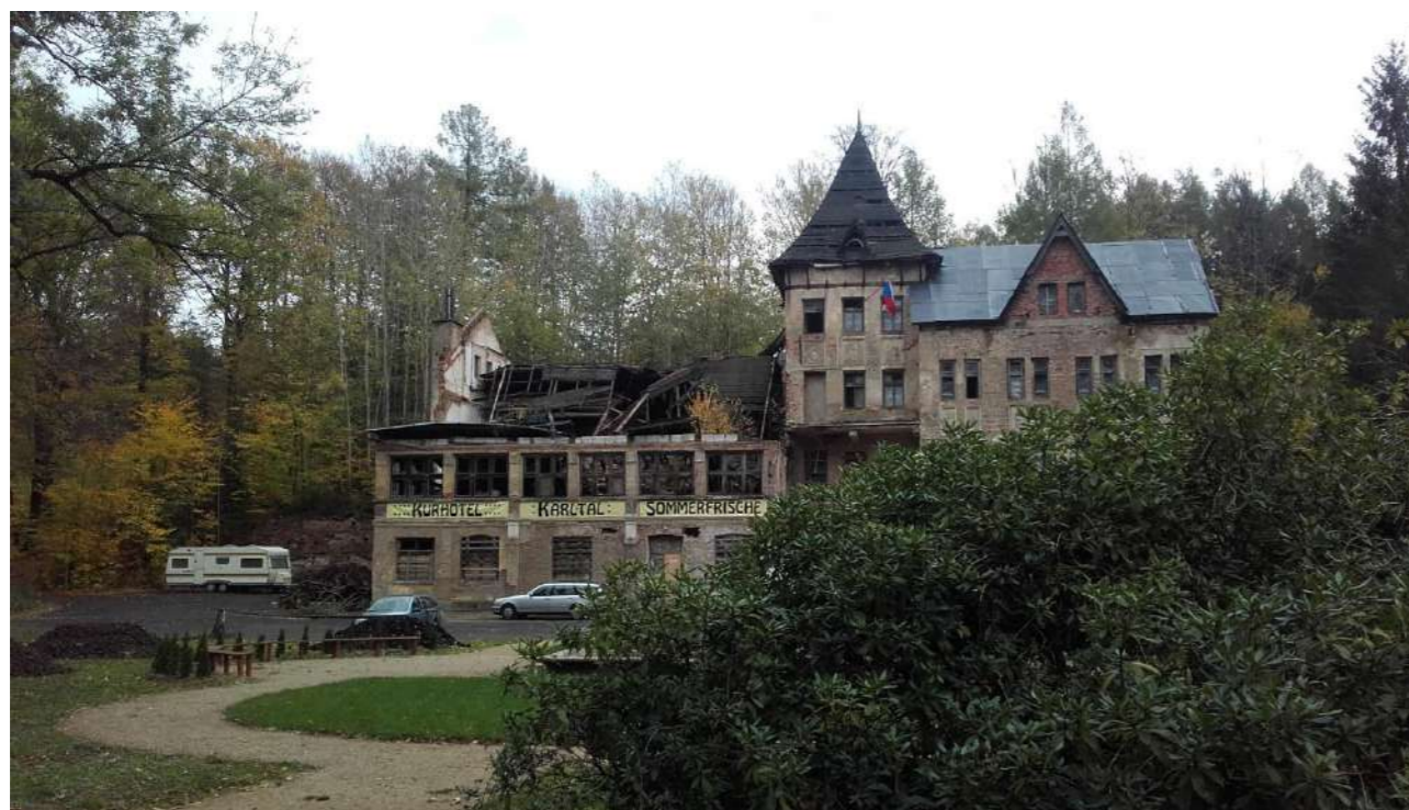
Obrázek 3: Střecha nad tanečním sálem [2]
