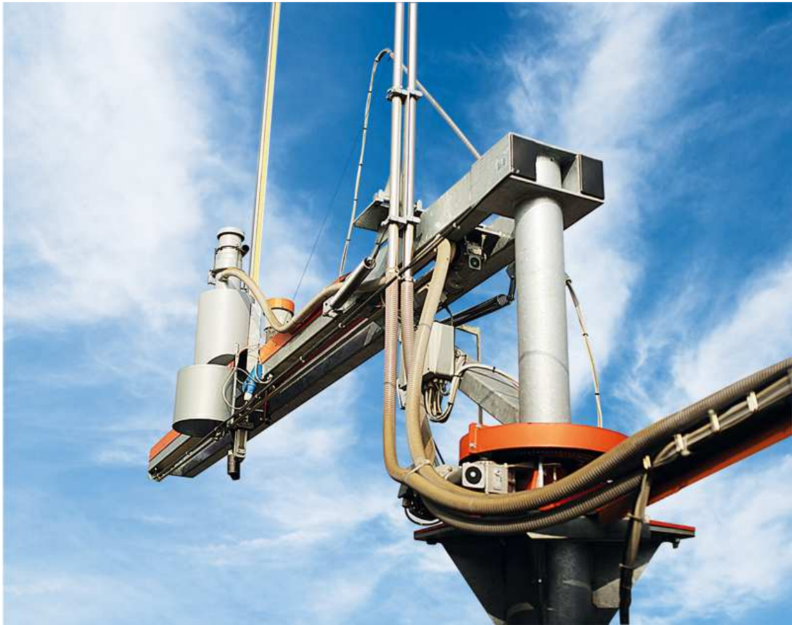
Obr. 13 Vedení hadic a kabelů na vzorkovači [11]
