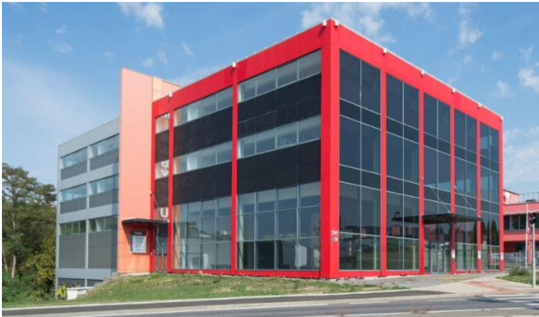
Obr. 4-1 – Administrativní budova v Kolbenově ulici [11]
