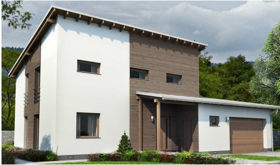
Obr. 1 Pohled na RD [32]
