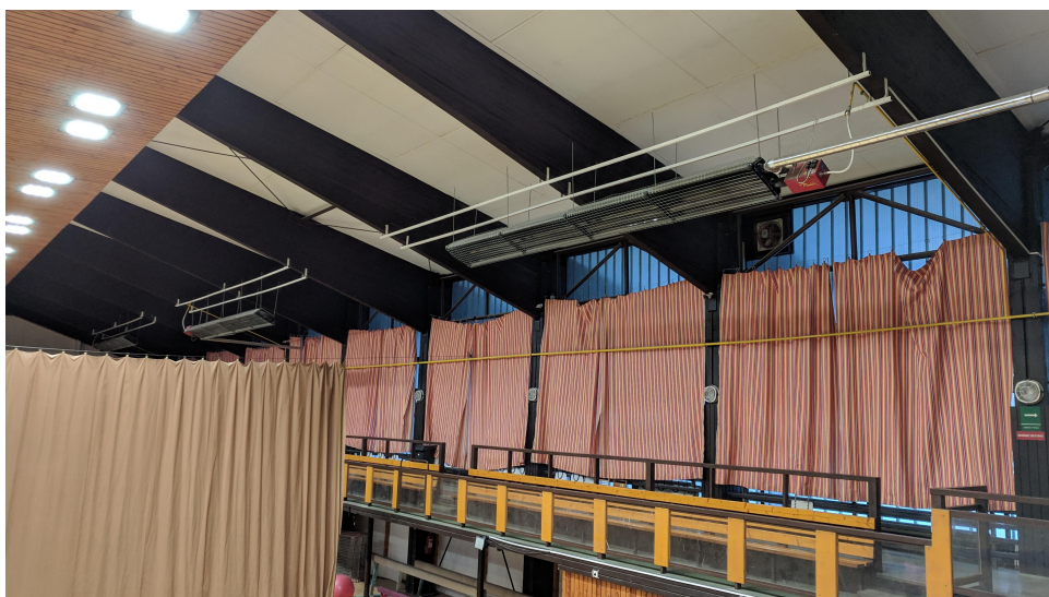
Obrázek 2.3: Foto plynových zářičů, závěsů a kopilitových desek sportovní haly TJ Jiskra. Leden 2019.
