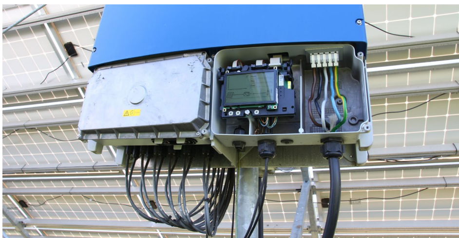
Obrázek 2.17 - pohled na zapojení střídače: vlevo zapojení 6 stringů, vpravo výstupní 3-fázové vedení.
