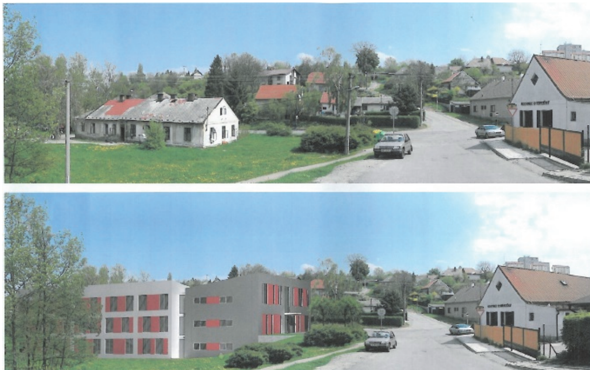
Obr. 5.63: Příklad kontroverzní novostavby azylového domu pro matky s dětmi (původně projektovaného jako dům na půl cesty) v Chrudim, který byl postaven v roce 2012. Zda tento projekt ctí genius loci místa je na zvážení čtenáře. Zdroj: http://chrudimskenoviny.cz/kategorie/zpravy/azyliku-mubasu-konci-udrzitelnost-co-s-nimi-dal
