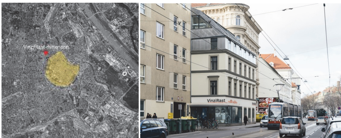
Obr. 5. 13 (vlevo) VinziRast-mittendrin, který je umístěn v adaptovaném historickém domě v širším centru Vídně.
