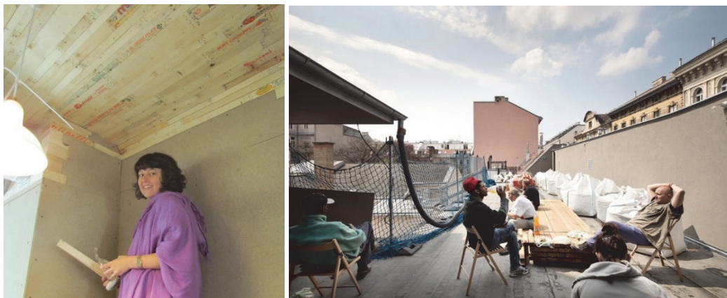
Obr. 5. 23 (vlevo): Budoucí obyvatelka VinziRast-mittendrin při tvorbě obkladů v interiéru restaurace, která se nachází v přízemí domu. Obklady jsou tvořeny prkénky z bedniček od ovoce, které by ve většině případů skončily v popelnici. Díky pečlivé práci tvůrců však dostanou druhou šanci, stejně jako obyvatelé domu.
