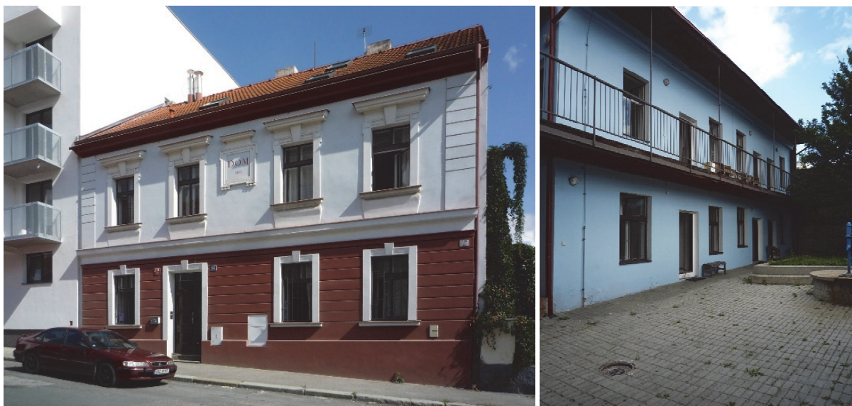
Obr. 3. 7, obr. 3. 8: Dům na půl cesty v Libni má dvě části – uliční trakt (vlevo) a dvorní část s pokoji (vpravo). Jednolůžkové pokoje jsou přístupné ze dvora a z pavlače. Foto: Karolína Kripnerová
