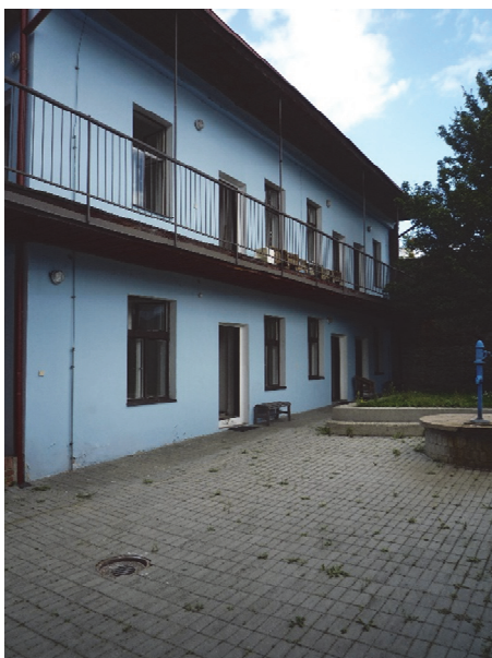
Obr. 5.4 (vlevo) Pokoje v domu na půl cesty DOM8 jsou přístupné po pavlači. Foto: Karolína Kripnerová
