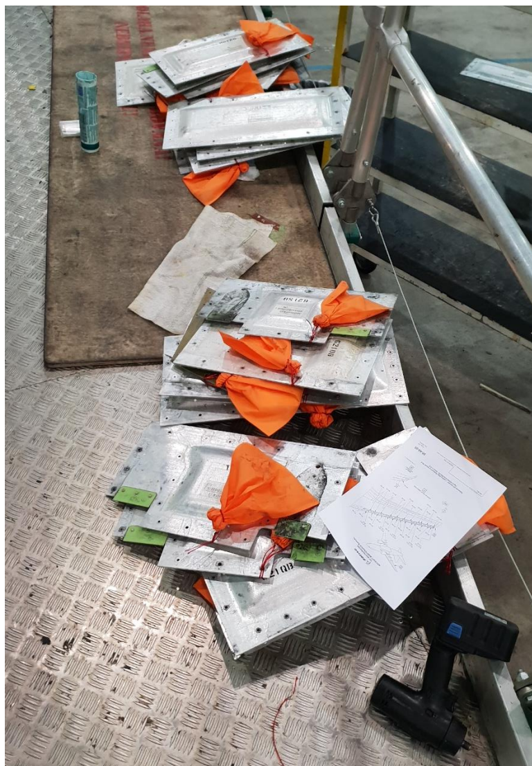
Obr.6 Dočasne demontované prístupové panely, čakajúce na uskladnenie. (foto autor)
