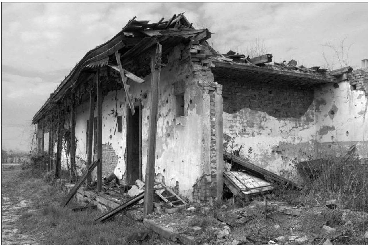
Obr. 23: Bežovce (okr. Sobrance) č. 246, pohľad od zadnej časti dvora na jeden z kedysi najvýstavných amerických domov dat. r. 1935. Údajne stál 3000 $. Vpravo zvyšok maštale, z ktorej sa zachovala ľavá špaleta dverí, jedno dvorové okienko so štukovou ilúziou tehlového záklenku, múr od suseda s otláčkom válova a 4 vetracími otvormi (15 x 15 cm) a jedno pole tehlovej segmentovej klenby v kolajnicovej traverze (foto autor 2016).
