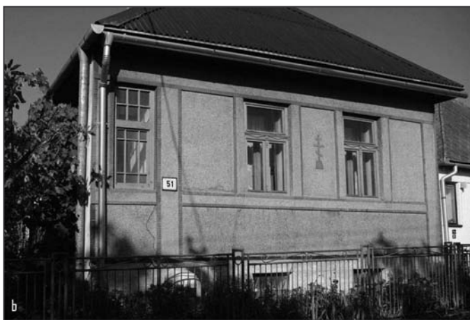
Obr. 8: Úpravy uličných fasád: a – Ptičie (okr. Humenné) č. 81, štuková fasáda z vápennej omietky a sadrových odliatkov (foto J. Hrabovský 2017); b – Kysta (okr. Trebišov) č. 51, na vidieku ojedinelá úprava fasády terazzovou omietkou (krytina, odkvapy a plot sú novšie, foto autor 2015).
