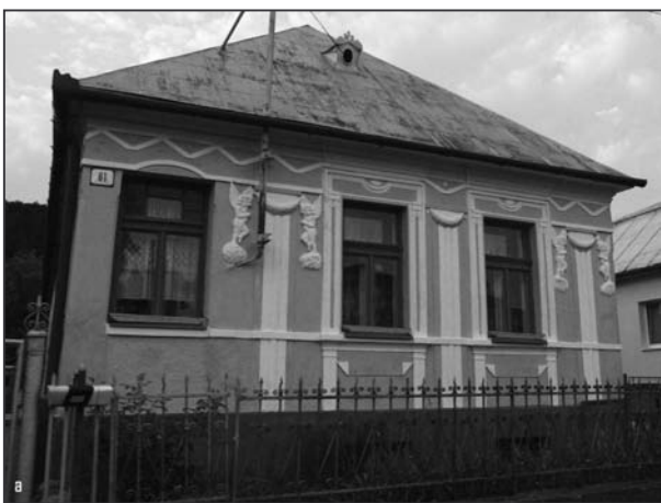
Obr. 8: Úpravy uličných fasád: a – Ptičie (okr. Humenné) č. 81, štuková fasáda z vápennej omietky a sadrových odliatkov (foto J. Hrabovský 2017); b – Kysta (okr. Trebišov) č. 51, na vidieku ojedinelá úprava fasády terazzovou omietkou (krytina, odkvapy a plot sú novšie, foto autor 2015).
