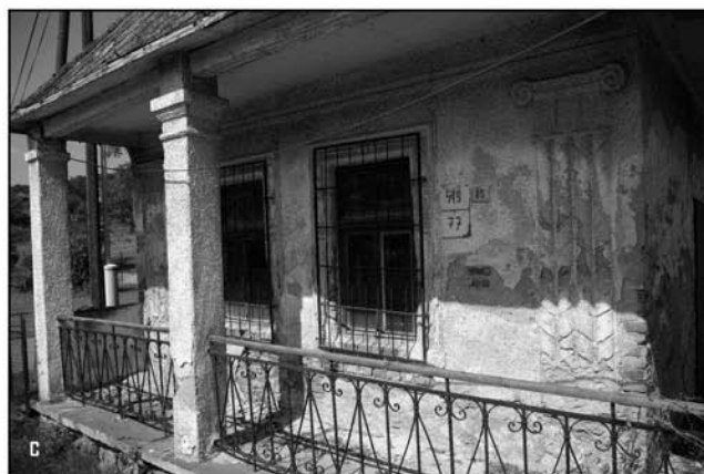
Obr. 14: Gánky amerických domov: a – Dúbravka (okr. Michalovce) č. 3, dom dat. r. 1931, dvojramenná drevená galéria s murovaným podbránkovým pilierom (foto autor 2016); b – Lastomír (okr. Michalovce) č. 239, murovaná dvorová galéria so stopami po drevenom zábradlí (foto autor 2011); c – Vranov n/Topľou-Dlhé, Dlhá ul. č. 77/519, dvojramenná murovaná galéria s kovaným zábradlím s dreveným madlom (foto autor 2016).
