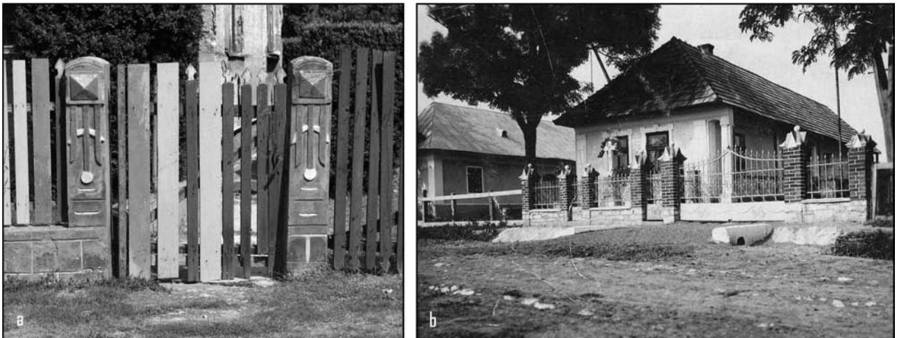
Obr. 22: Ploty, brány, bránky a kríže: a – Kapušianske Kľačany (okr. Michalovce) č. 46, bránka v plote z betónových pilierov so secesným reliéfom. Užšie latky – „štachitki“ – so zahrotenými hlavičkami sú zvyškom pôvodnej drevenej výplne (foto autor 2012); b – Budkovce (okr. Michalovce) č. 42, dom spreď r. 1924, kovaný plot medzi murovanými piliermi po r. 1924, kríž v predzáhradke nesie na piedestáli nápis: „TEN SVÁTY KRÍŽ / DAĽ POSTAVIC / NIKOLAJ ILKO / A JEHO MANŽELKA / ANNA HRICOVÁ / A JICH DCERA ANNA / 1928“ (nedatovaná fotografia neznámeho autora v zbierke MUDr. J. Dobrovolského).
