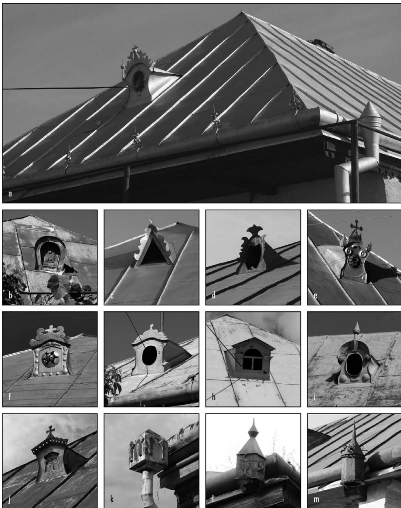
Obr. 19: Plechová krytina a jej klampiarske detaily – „kukovki“ a „kotličky“ (všetky príklady okr. Michalovce): a – Falkušovce č. 114; b – Ižkovce č. 31; c – Petrikovce č. 67; d – Ložín č. 78; e – Strážske č. 237; f – Dúbravka č. 3; g – Beša č. 123; h – Trhovište č. 371; i – Jastrabie pri Michalovciach č. 4; j – Zemplínska Široká č. 20; k – Malčice č. 211; l – Trhovište č. 161; m – Veľké Raškovce č. 43 (foto autor 2015–2016).
