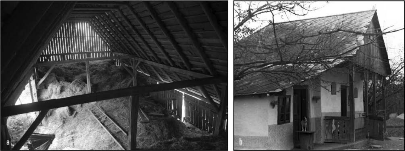
Obr. 21: Z hospodárskeho zázemia amerických obydľí: a – Šamudovce (okr. Michalovce) č. 116. Medzivojnové stodoly na východnom Slovensku sú tradične priečne priečhodné, opláštňované kúpenskými doskami a kryté tvrdými nehorľavými krytinami (foto autor 2016); b – Stretava (okr. Michalovce), č. neuvedené, komora s pristavanou letnou kuchynkou materiálom a výtvarne poplatná súdobému obytnému domu: je murovaná z pálenej tehly, má nehorľavú krytinu a vyrezávaný drevený gánok (foto M. Bohucký 1972, archív ÚEt SAV v Bratislave, inv. č. AN078467).
