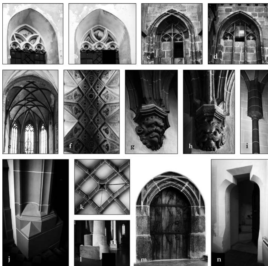
Obr. 5. Analógie tvaroslovia neskorogotickej prestavby kostola: a, b – Tășnad (Rumunsko), reformovaný kostol, kružby chórových okien. Zdroj: http://temple-tour.eu ; c, d – Košice, Dóm sv. Alžbety, kružby okien sakristie. Foto: Maroš Volovár, 2017; e – Bardejov, Kostol sv. Egídia, chórová klenba. Foto: Maroš Volovár, 2008; f – Seon am Chiemsee (Nemecko), benediktínsky kostol, klenba lode. Zdroj: http://www.tagschmetterlinge.de ; g, h – Košice, Dóm sv. Alžbety, konzoly klenby sakristie. Foto (g): Maroš Volovár, 2007. Zdroj (h): https://www.slovakiana.sk ; i, j – Košice, Dóm sv. Alžbety, Szatmáriovská kaplnka, prípora s cylindrickou hlavicou a päťka vstupnej arkády. Foto: Maroš Volovár, 2016; k – Košice, Dóm sv. Alžbety, detail klenby oratória nad južnou predsieňou. Foto: Maroš Volovár, 2016; l – Sarospatak (Maďarsko), farský kostol, päťky medzilodových pilierov. Foto: Maroš Volovár, 2006; m – Berchtesgaden (Nemecko), augustiniánsky kostol, portál do sakristie. Zdroj: http://www.burgenseite.com ; n – Košice, Dóm sv. Alžbety, sakristia, portál točitého schodiska. Foto: Maroš Volovár, 2007.
