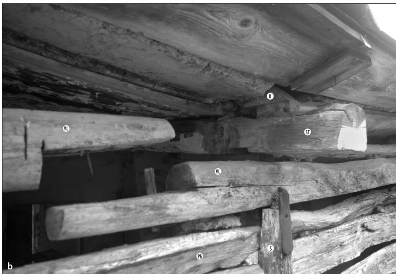
Obr. 9: Koromľa (okr. Sobrance), č. 114, skladba rámovej steny na odhalenej SV fasáde domu: a – v rozsahu stredného travé (foto autor 2013); b – detail (foto autor 2019). Skratky prvkov ako v popise obr. 7.
