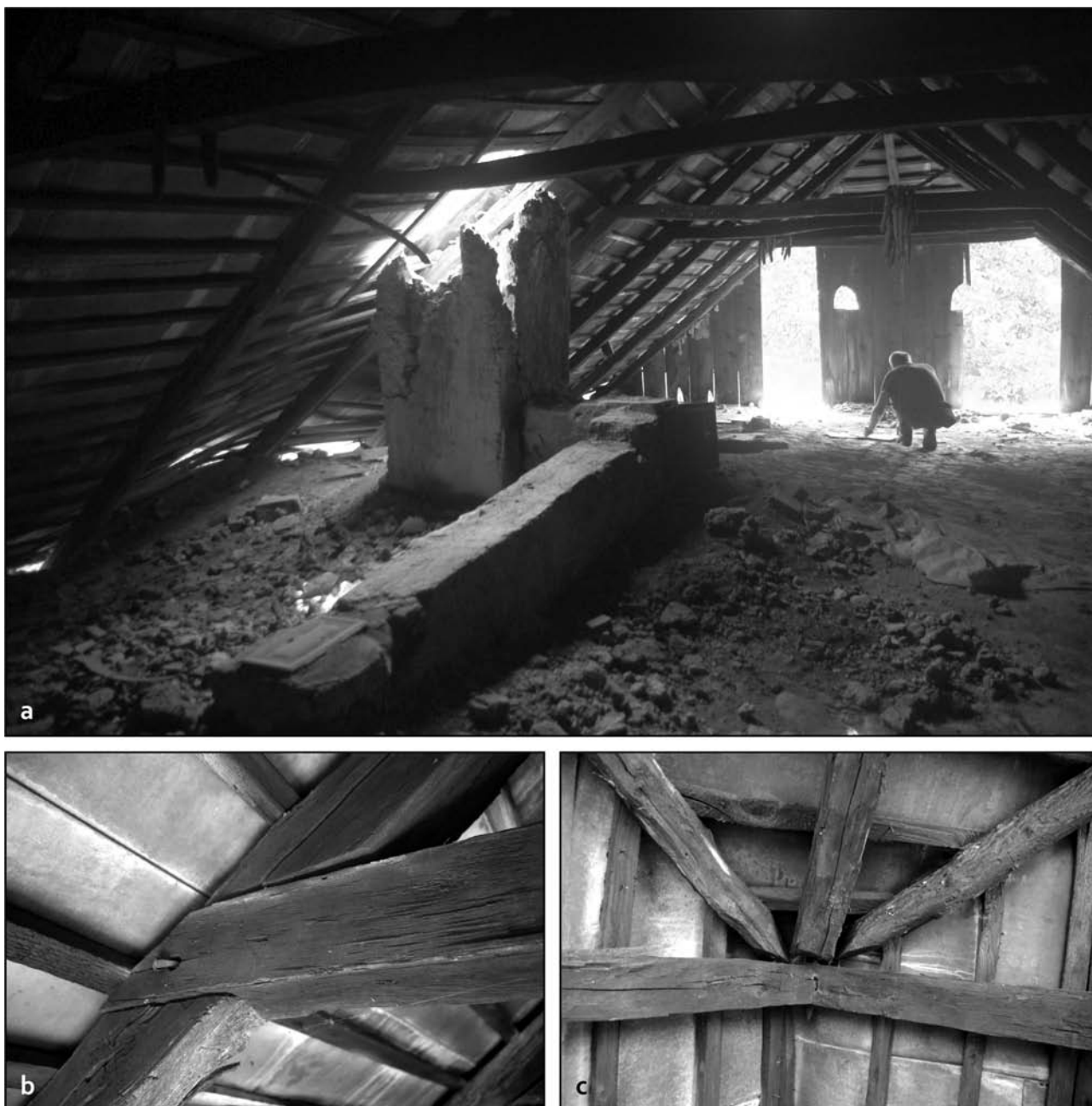
Obr. 14: Koromľa (okr. Sobrance), č. 114, povala: a – pohľad k JV štítu, hambáľkový krov a tehlový dymovod z komína v západnom kúte kuchyne (II) do zvyšku hlavného, pod strešnou rovinou len hlineného komína; b – rovné preplátovanie hambáľku a krokvy; c – stret priečných, diagonálnych a pozdĺžnej krokvy vo vrchole JV valby (foto autor 2018, 2019).
