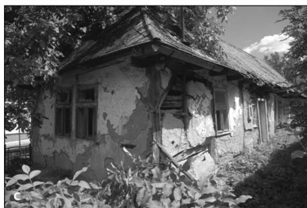
Obr. 6: Korumľa (okr. Sobrance), posledné jednotraktové domy rámovej konštrukcie v obci: a – č. 107, š = 5 m, dendro: 1913 – 1916 (citácia v pozn. 23, foto autor 2013); b – č. 132 (foto autor 2013); c – č. 157, š = 4,8 m, dendro: 1935 – 1936 (citácia v pozn. 23, foto autor 2018).
