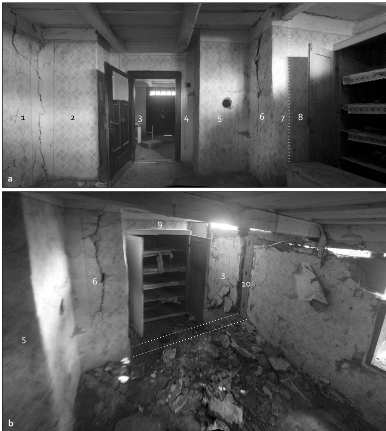
Obr. 20: Krišovská Liesková-Krížany (okr. Michalovce), č. 67, kuchyňa (II): a – pohľad na JZ stenu, ku vchodu; b – pohľad do severnej časti, vzadu je výklenok vytvorený rozšírením kuchyne na úkor komory (III), bodkované čiary naznačujú priebeh pôvodnej priečky (obe fotografie autor 2019).
