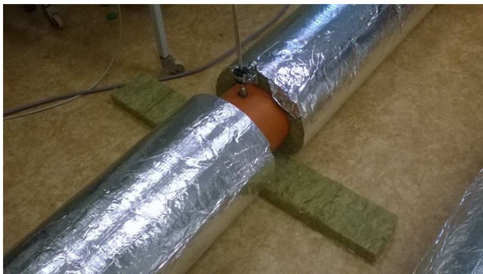
Obr. 44 – Umístění anemometru KIMO SVH14 do potrubního prvku ODA.
