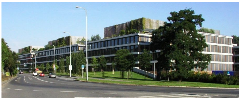
Obr. 1 Pohled na budovu ABX z jihovýchodu
