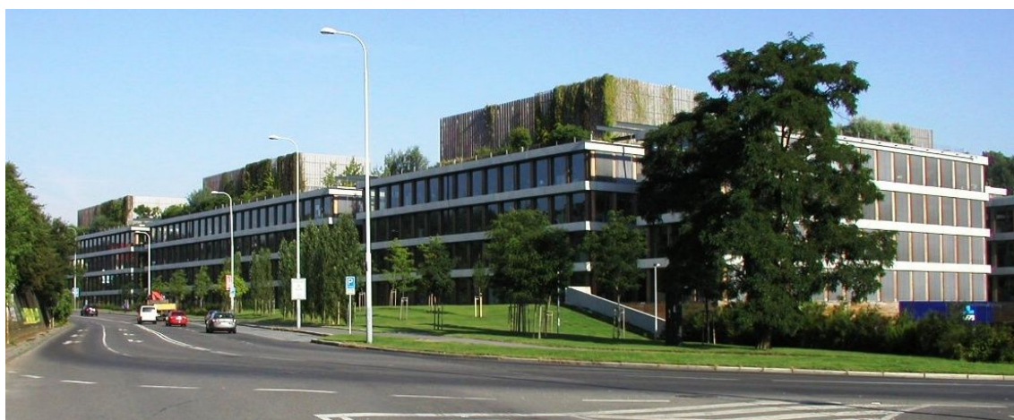
Obr. 1 Pohled na budovu ABX z jihovýchodu
