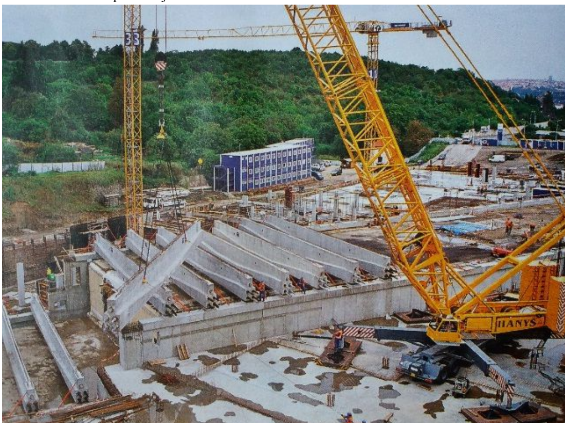
Obr. 5 Překlenutí tubusu metra 25
