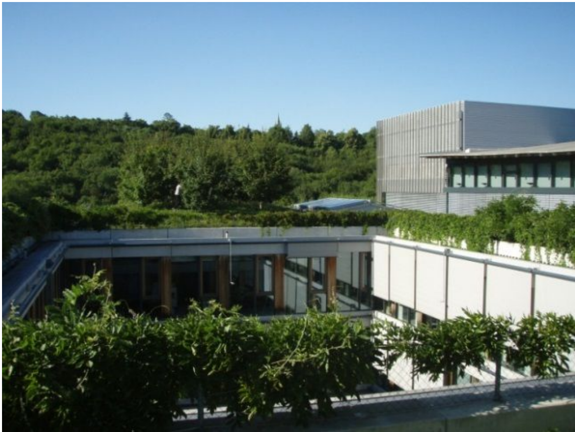
Obr. 2 Střešní zahrada, prolínání s okolím
