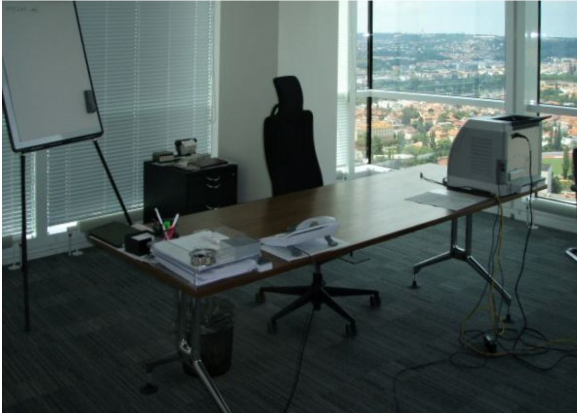
Obr. 44 Nevhodné umístění lamelového clonění v interiéru
