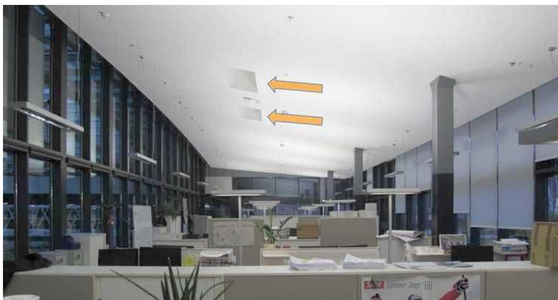
Obr. 55 Otvory pro možnost přirozeného větrání
