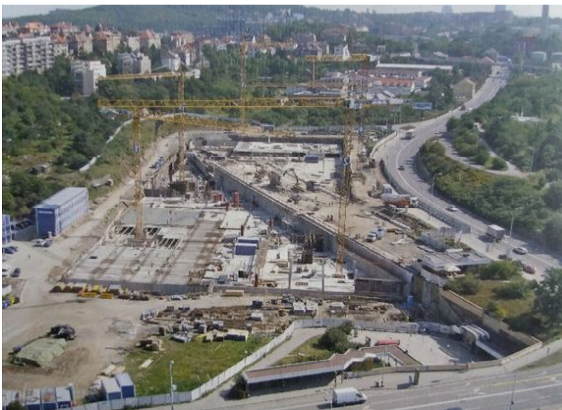
Obr. 4 Tubus metra procházející budovou a 2.PP 24
