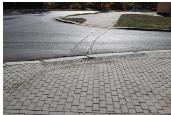
Obr. 50 : Úsek č. 50 – Chybně provedené bezpečnostní prvky pro nevidomé a slabozraké na místě pro přecházení 72
