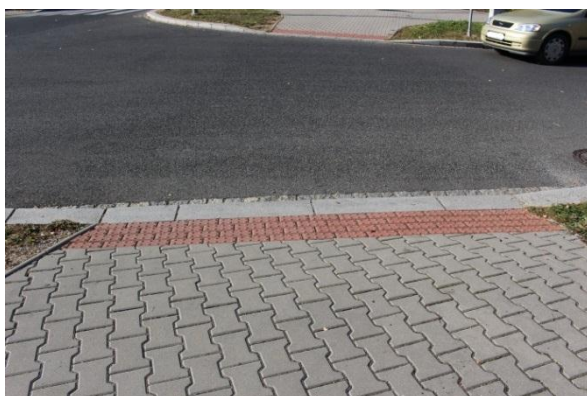
Obr. 30 : Úsek č. 23 – Chybně provedené bezpečnostní prvky pro nevidomé a slabozraké na místě pro přecházení 60
