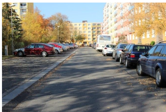
Obr. 47 : Úsek č. 45 – Nedostatečný průjezdný profil 70
