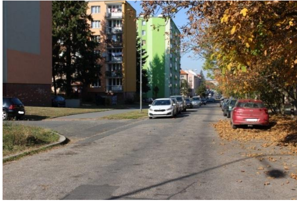
Obr. 34 : Úsek č. 27 – Nedostatečný průjezdny profil 63
