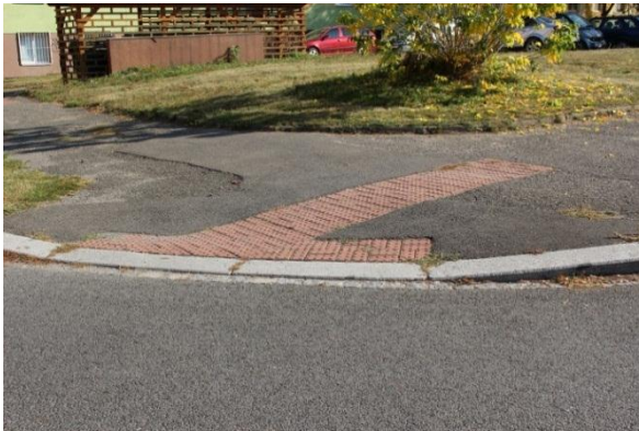
Obr. 33 : Úsek č. 27 – Chybně provedené bezpečnostní prvky pro nevidomé a slabozraké na místě pro přecházení 62
