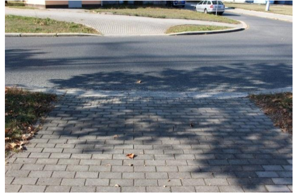
Obr. 53 : Úsek č. 53 – Chybně provedené bezpečnostní prvky pro nevidomé a slabozraké na místě pro přecházení 74
