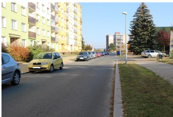
Obr. 37 : Úsek č. 28 – Nedostatečný průjezdný profil 64
