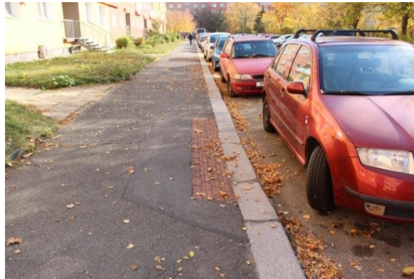
Obr. 46 : Úsek č. 45 – Chybně provedené bezpečnostní prvky pro nevidomé a slabozraké na místě pro přecházení 70
