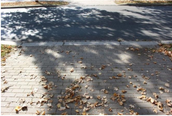
Obr. 53 : Úsek č. 53 – Chybně provedené bezpečnostní prvky pro nevidomé a slabozraké na místě pro přecházení 74
