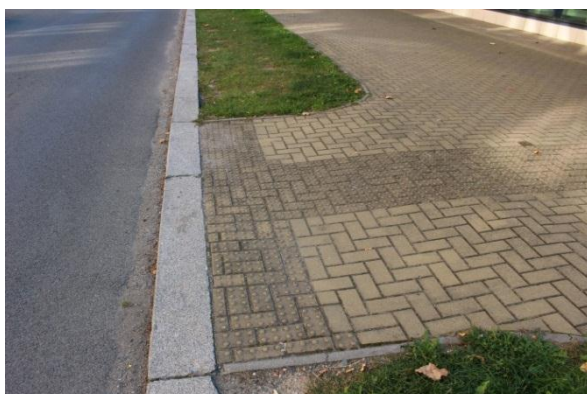
Obr. 36 : Úsek č. 28 – Chybně provedené bezpečnostní prvky pro nevidomé a slabozraké na místech pro přecházení 64
