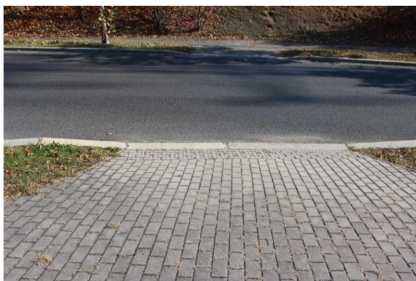
Obr. 50 : Úsek č. 50 – Chybně provedené bezpečnostní prvky pro nevidomé a slabozraké na místě pro přecházení 72
