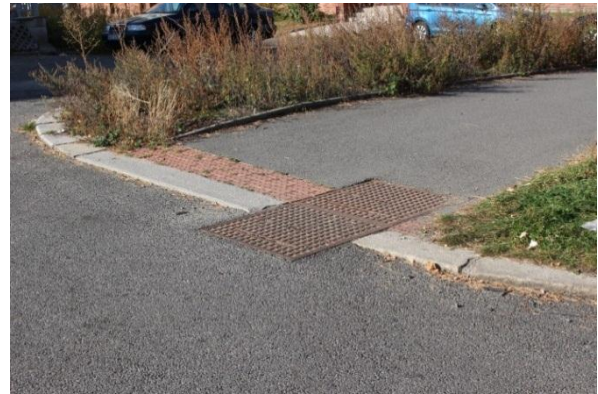
Obr. 33 : Úsek č. 27 – Chybně provedené bezpečnostní prvky pro nevidomé a slabozraké na místě pro přecházení 62
