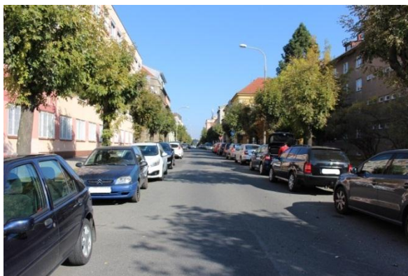
Obr. 19 : Úsek č. 9 – Nedostatečný průjezdný profil 53
