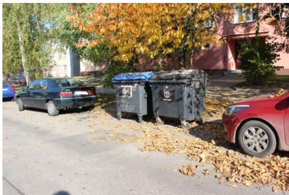
Obr. 35 : Úsek č. 27 – Nevhodné umístění kontejneru na odpady 63
