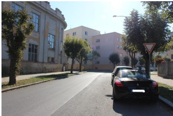
Obr. 8 : Úsek č. 1 – Nevhodně umístěné SDZ o přednosti v jízdě 45
