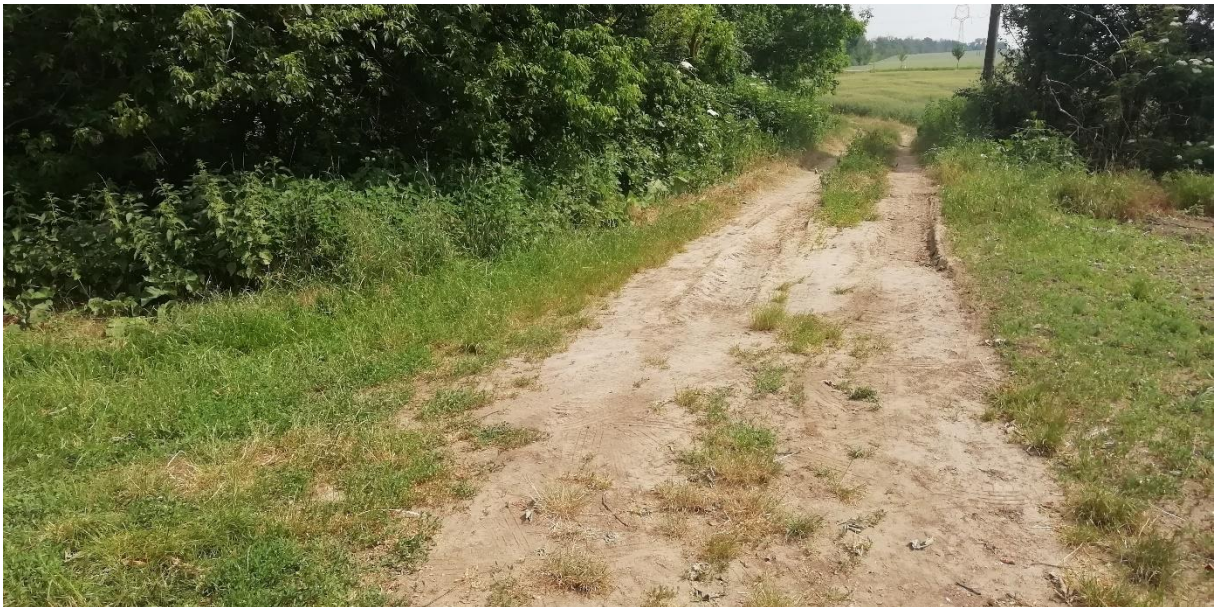
Obrázek 34: Přejezd přes potok Prušánka
