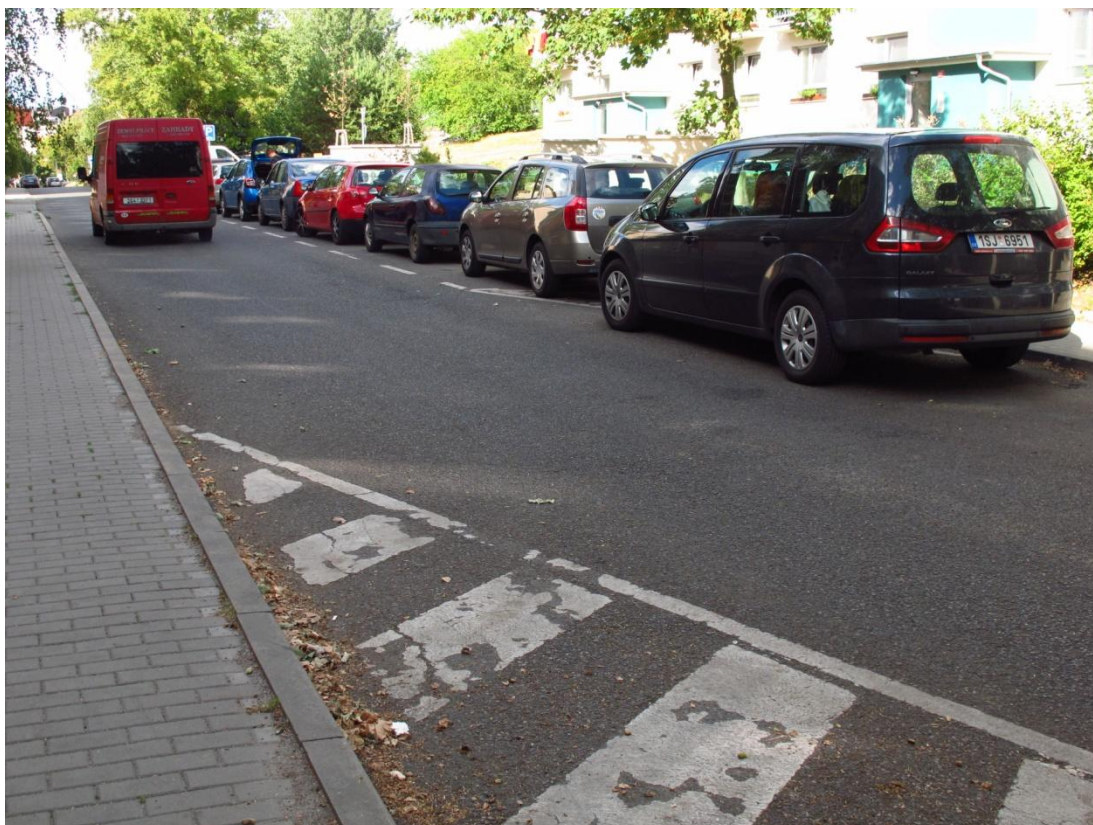
Obrázek 68 - podélné odstavné pruhy v ulici Braniborská – podobným způsobem je řešené odstavování vozidel v téměř celé délce ulice – část B
