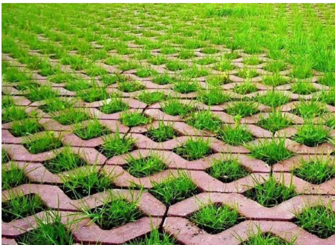
Obrázek 109 - zatravňovací dlaždice [24]
