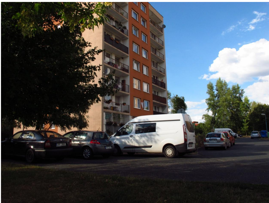
Obrázek 47 - pohled na odstavňnou plochu u bytového domu č. p. 604 - část 604
