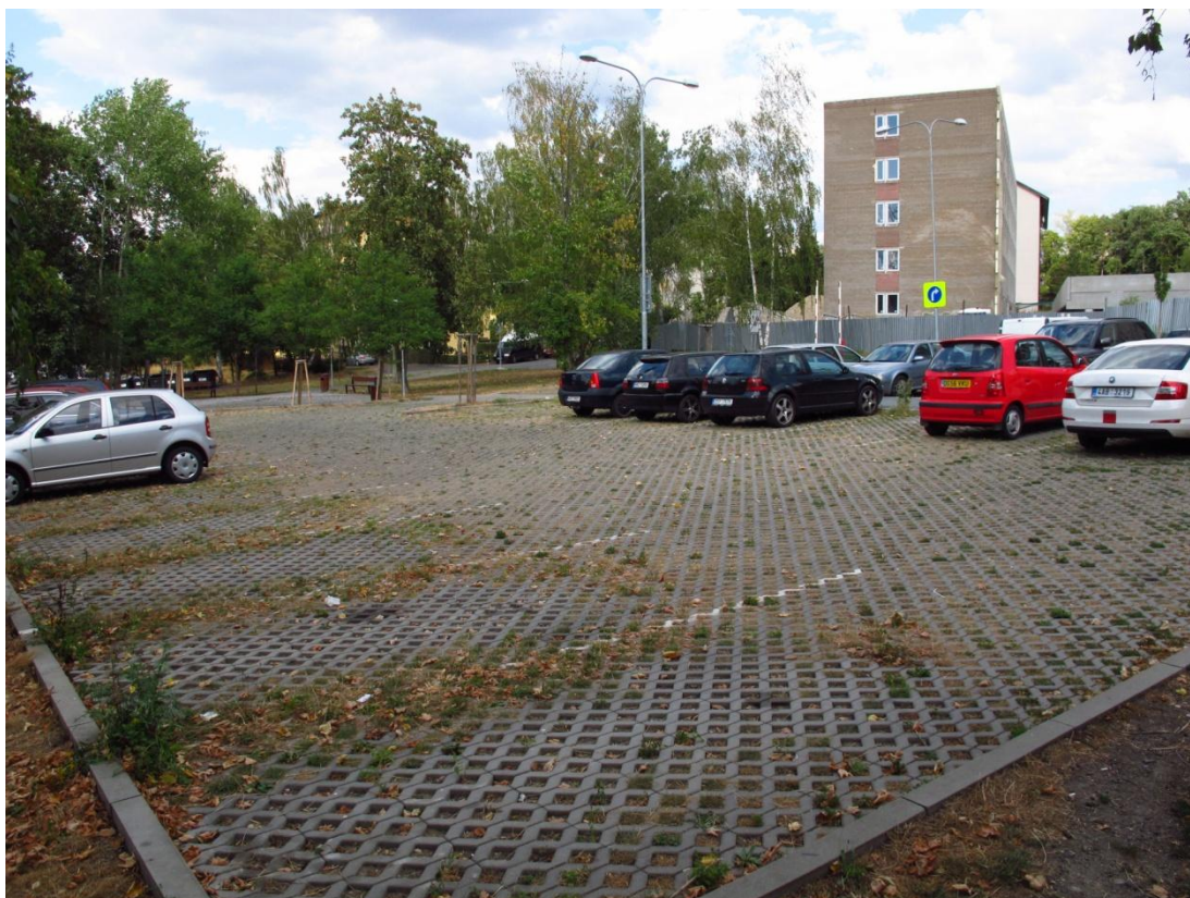
Obrázek 76 - pohled na celou odstavnou plochu poblíž základní školy – část C
