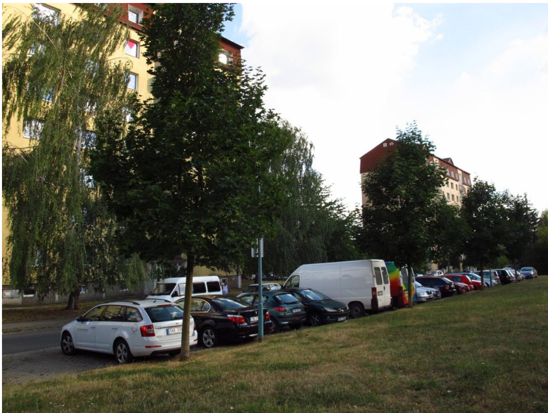
Obrázek 45 - pohled na odstavnou plochu u bytového domu Sportovní č. p. 602 - část 602
