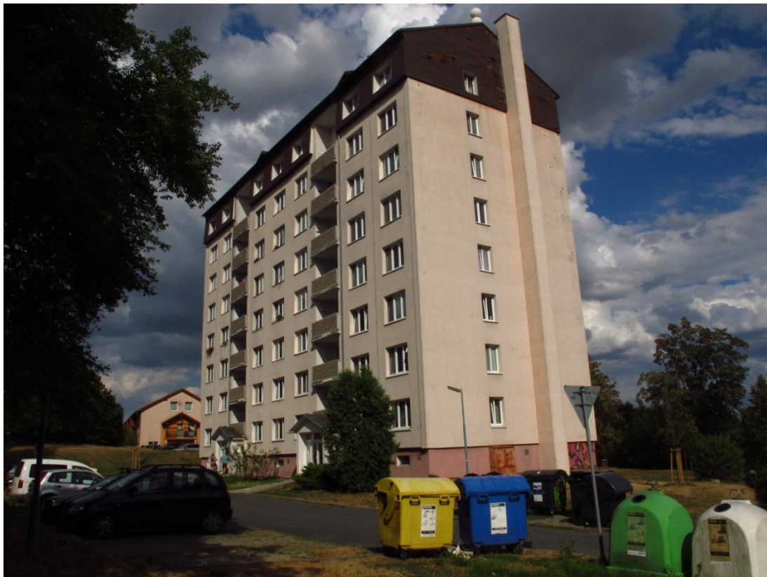
Obrázek 90 – pohled na odstavnou plochu u bytového domu Armádní 500 – část 500
