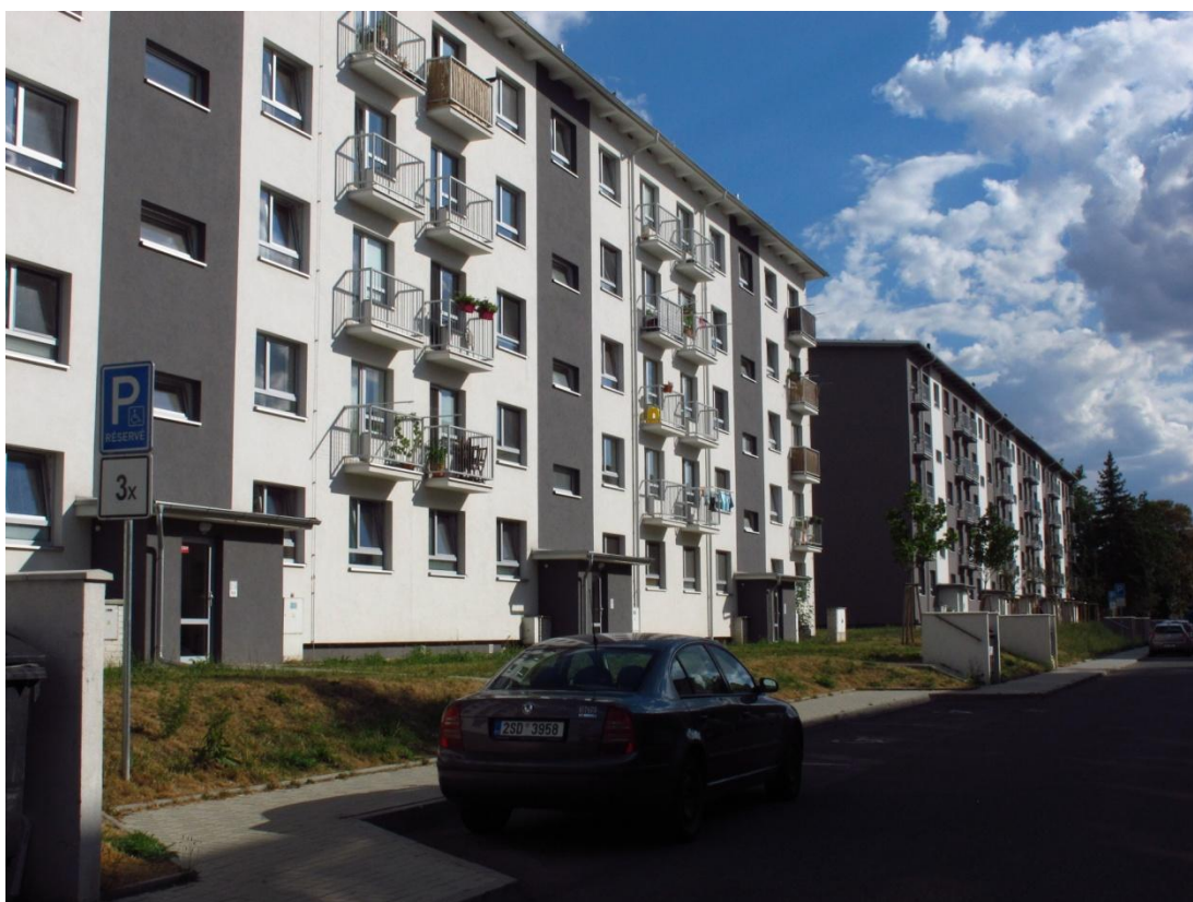
Obrázek 83 - pohled na vyhrazená podélná stání před bytovým domem Spojovací 1307 - část S
