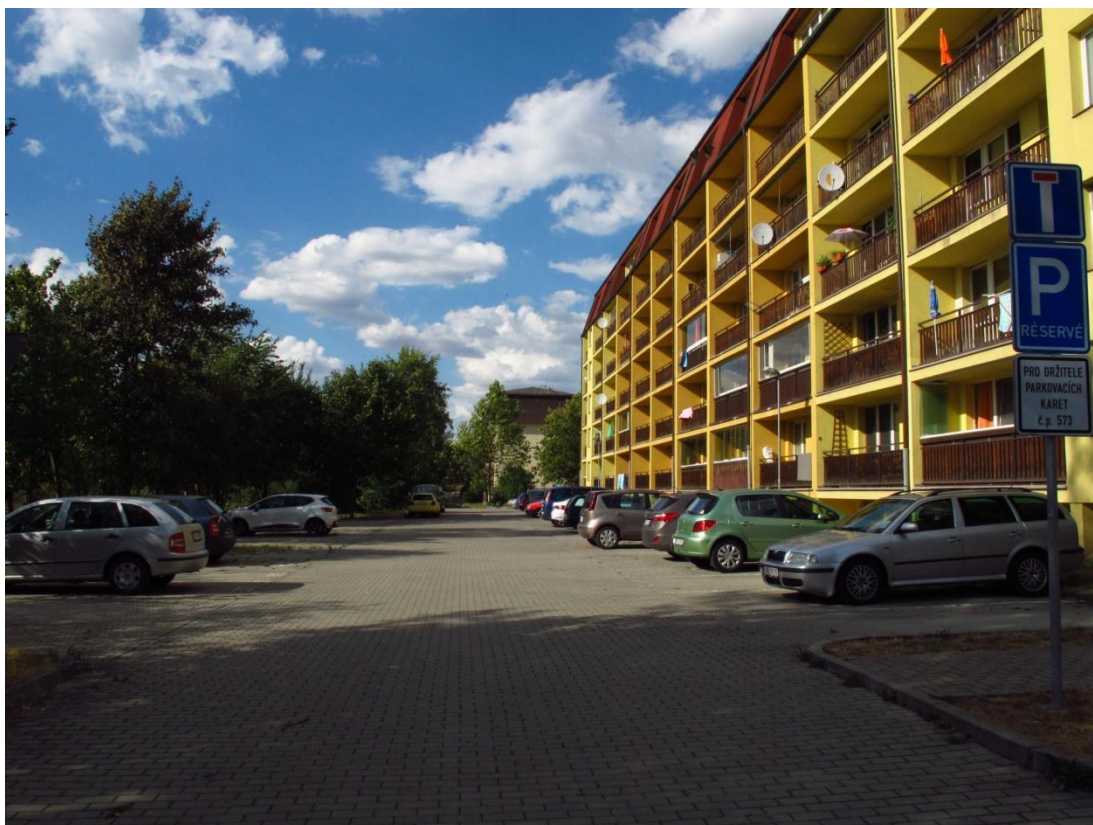
Obrázek 62 - následující fotografie je zaměřena na odstavňovou plochu ze západu bytového domu Višňová 573 - část T
