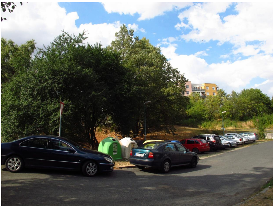
Obrázek 92 - pohled na odstavnou plochu u bytového domu Armádní 502 - část 502
