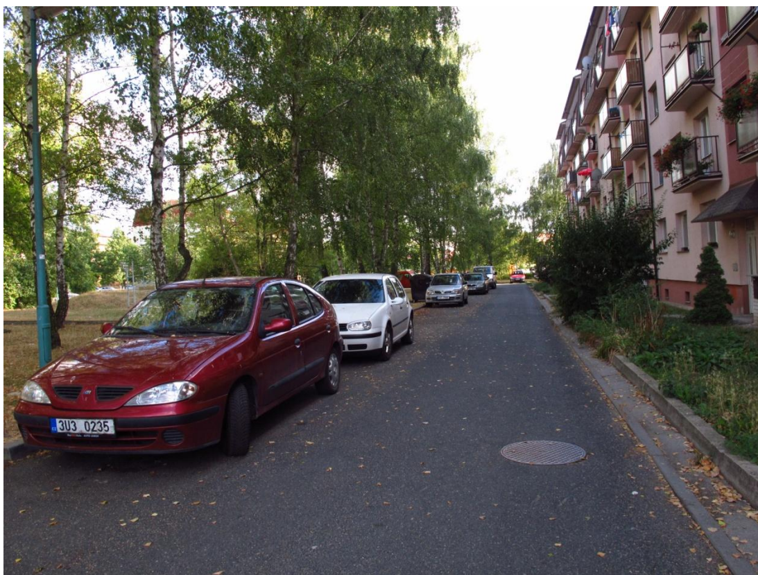
Obrázek 55 - pohled zachycuje přístupovou silnici u bytových domů Tyršova 609-613 - část L
