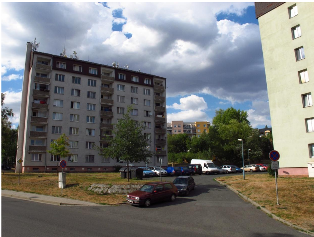
Obrázek 91 – fotografie zachycuje odstavnou plochu u bytového domu Armádní 501 - část 501
