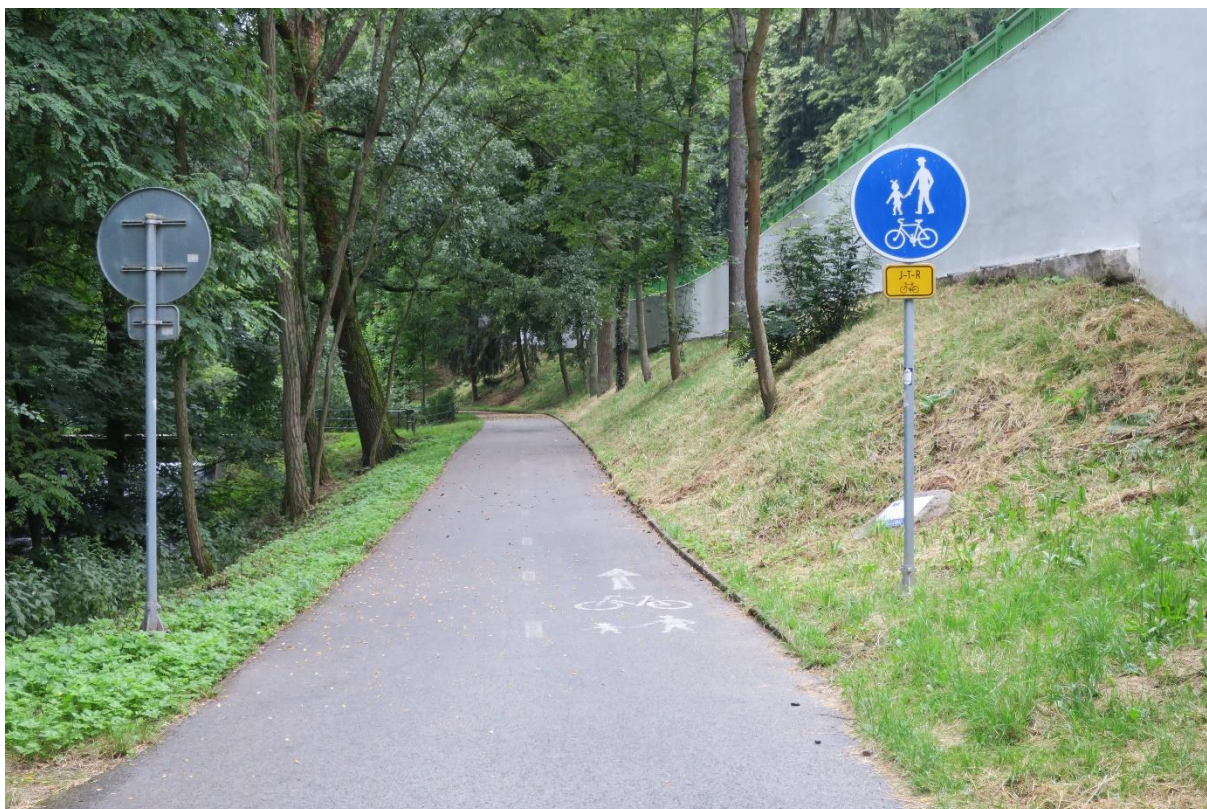
Obr. 3.14: Asfaltový kryt pod Borovinským mostem s ukázkou vodorovného značení.
