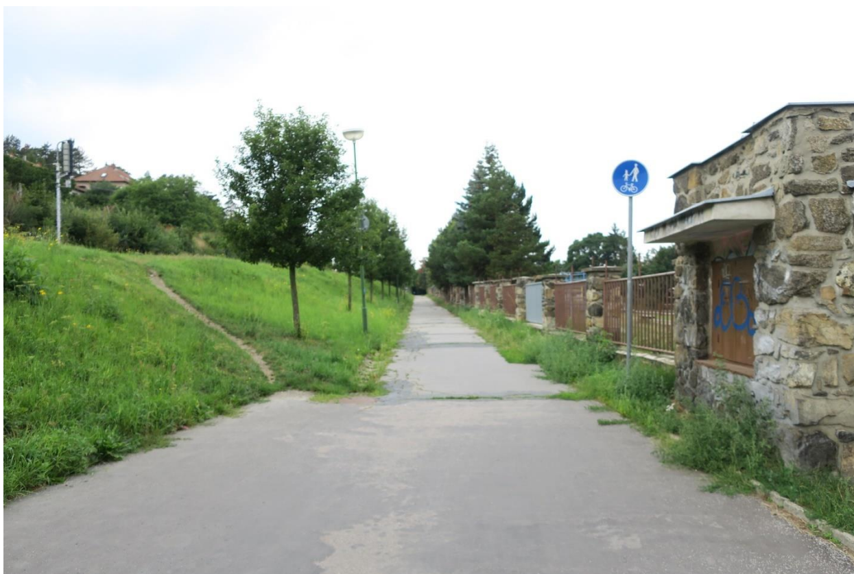
Obr. 3.10: Stezka pro chodce a cyklisty společná pohled z ulice Máchalova podél železniční trati.
