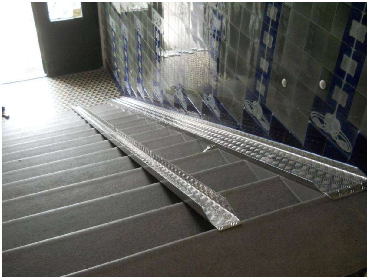
Obr. 4.12: Názorný příklad rampy pro kola a kočárky. [14]
