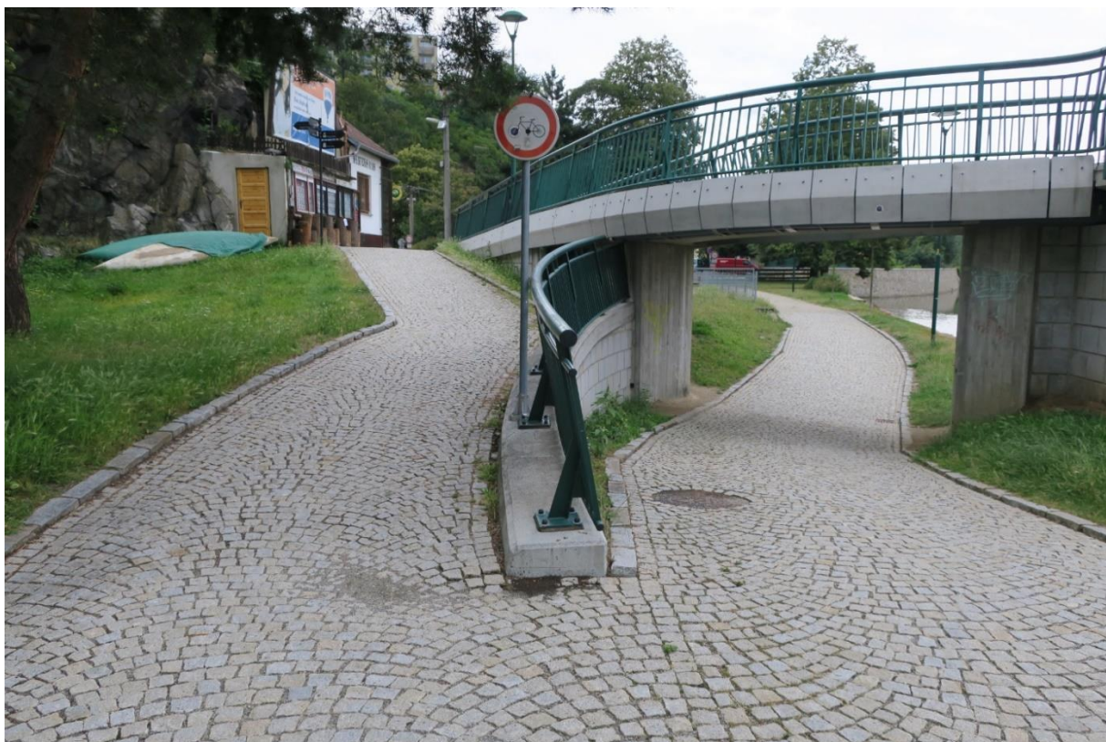
Obr. 3.19: Příklad nevhodného umístění zákazového svislého značení na společné stezce pro chodce a cyklisty.
