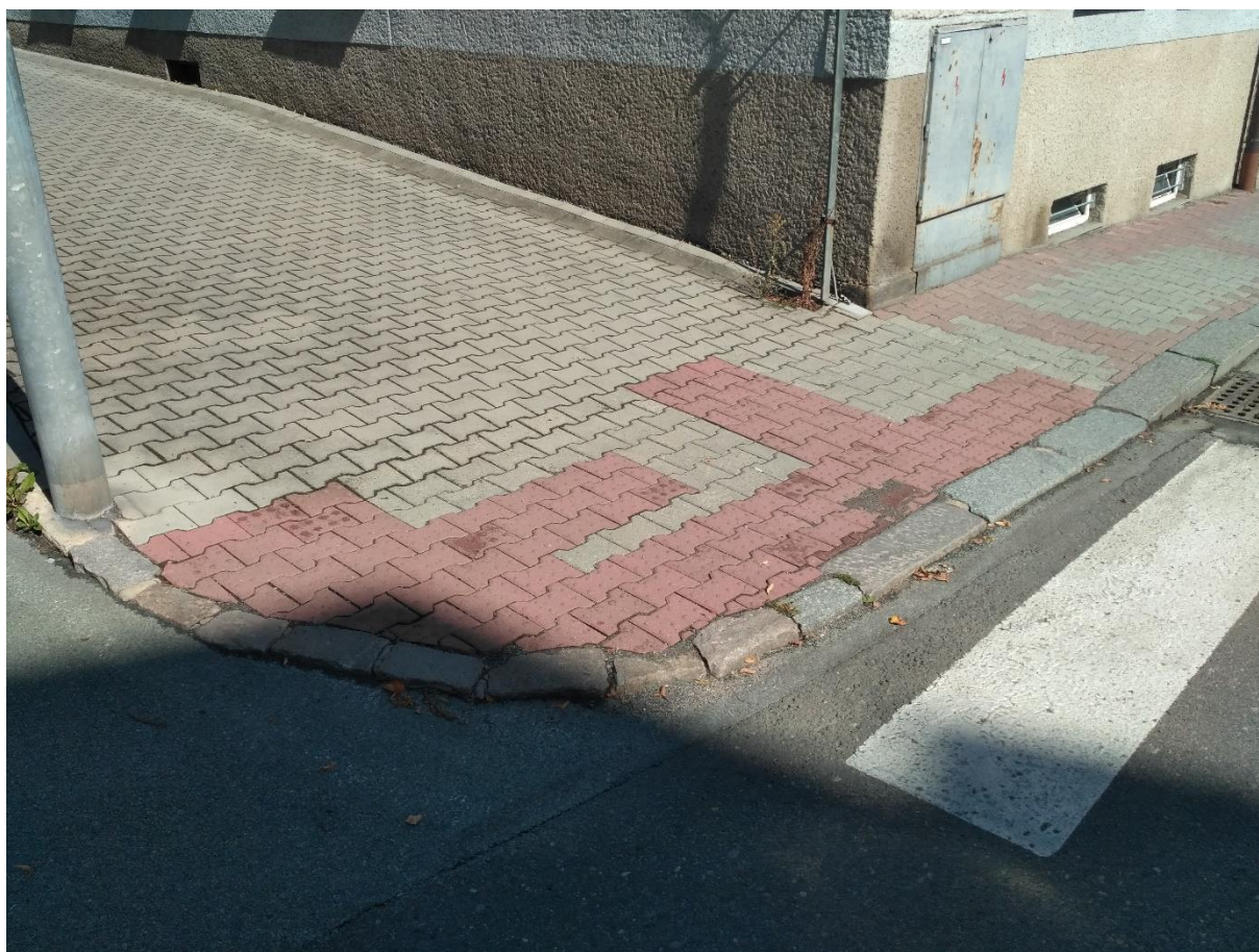
Obrázek 19 - Nesprávně řešené hmatové prvky pro nevidomé
