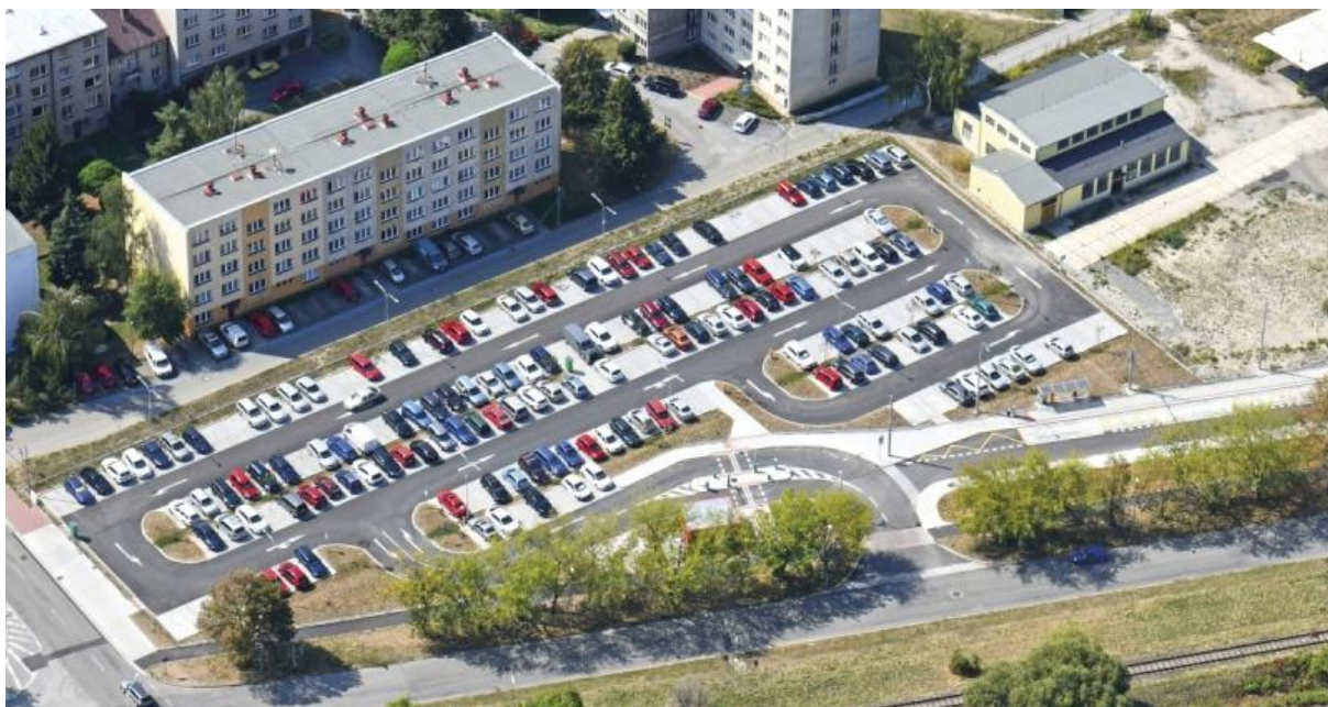
Obrázek 6-Pohled na I.etapu parkoviště Jírovцова [zdroj: www.konstrukce.cz]
