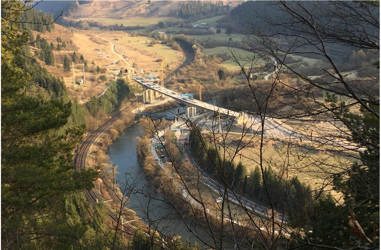
Príloha 3. Letecký záber na časť diaľničného úseku. (archív Ing. Bohúň)
