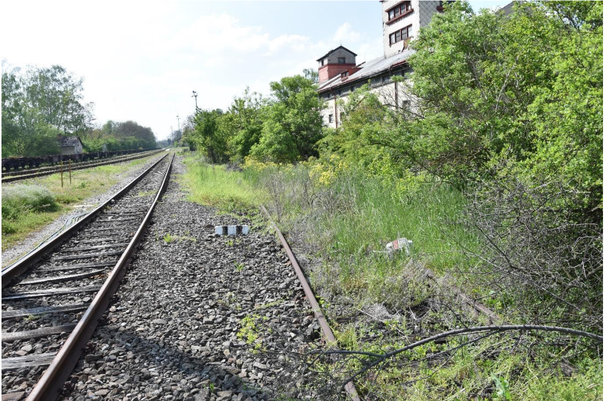
Obrázek 17: Pohled na odvratnou kolej číslo 5 (vpravo). Kolej pokračuje v délce dalších cca 90 metrů ve křoví. Místy je kolej zborcená.[31]
