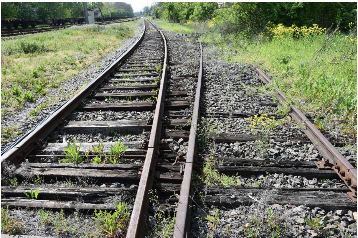
Obrázek 18: Detail pražců u kolejového rozvětvení mezi kolejemi 3 a 5.[31]
