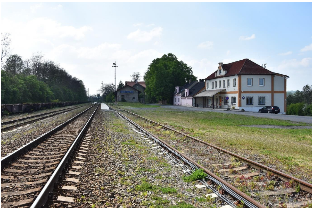
Obrázek 14: Rozšířená oblast přednádraží – pohled z kolejiště. Vpravo obecní úřad a pošta, uprostřed vzadu skladiště s rampou a za ním část výpravní budovy.[31]
