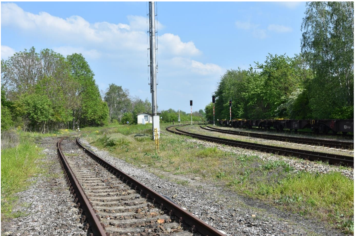
Obrázek 12: Fotografie odsazení jedné z kolejí u turnovského zhlaví.[31]
