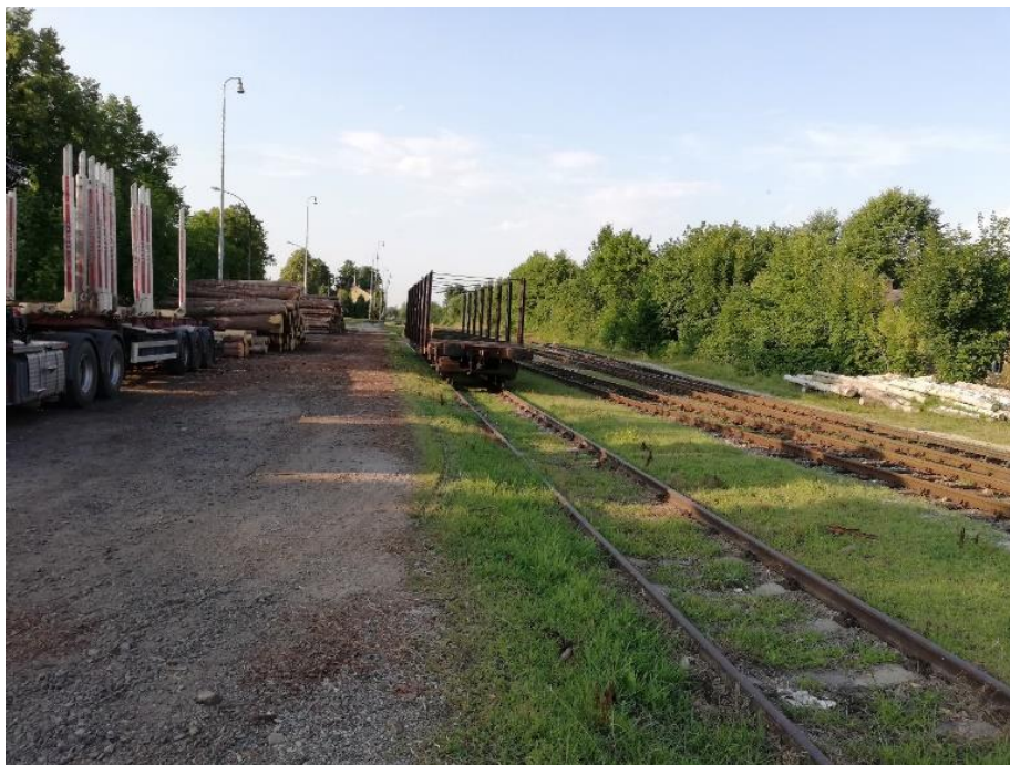
Obrázek 17: Pohled na třeboňské zhlaví železniční stanice Lomnice nad Lužnicí.
