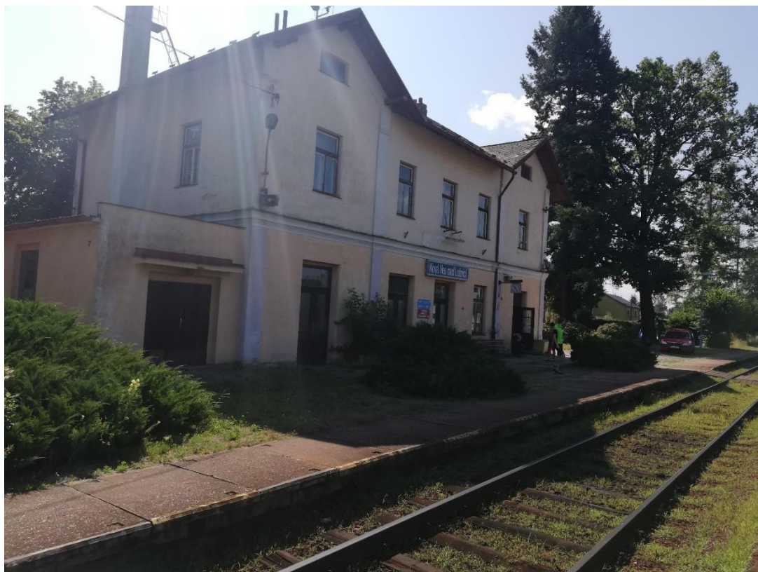
Obrázek 29: Výpravní budova stanice Nová ves nad Lužnicí
