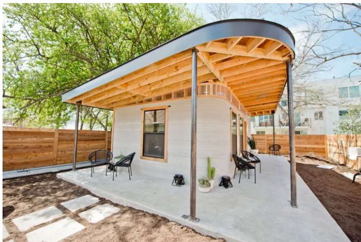
Obr. 4- Dům vyrobený pomocí aditivní technologie [9]
