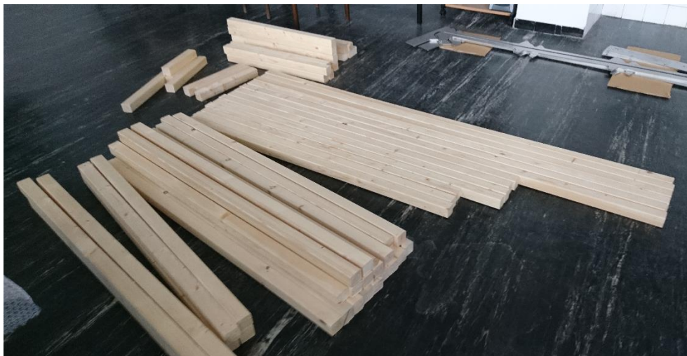
Obrázek 56: Nařezané trámy pro rám
