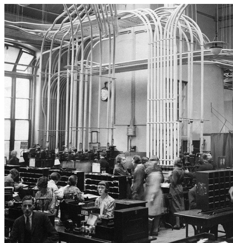
Obr. 15.: Přejímky potrubní pošty – Londýn [10] Obr. 14.: Instalované potrubí – Londýn [10]
