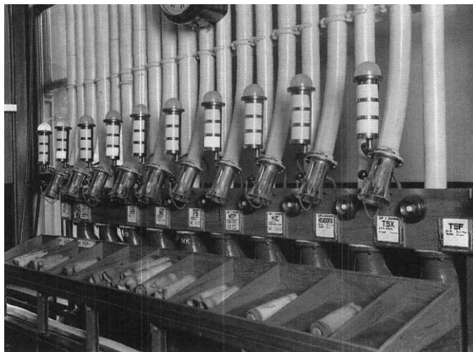
Obr. 15.: Přejímky potrubní pošty – Londýn [10] Obr. 14.: Instalované potrubí – Londýn [10]
