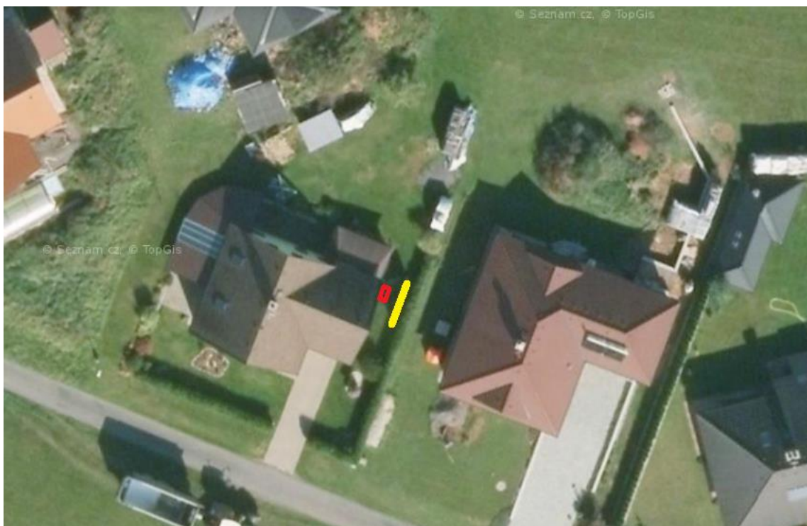
Obr. 38 Letecký snímek s vyznačeným tepelným čerpadlem a protihlukovou bariérou
