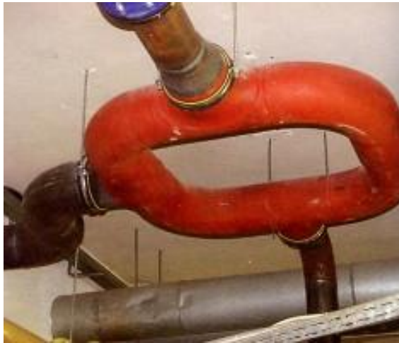
Obr. 6.15 – Pohled na hydraulický věnec – vlevo [19]
