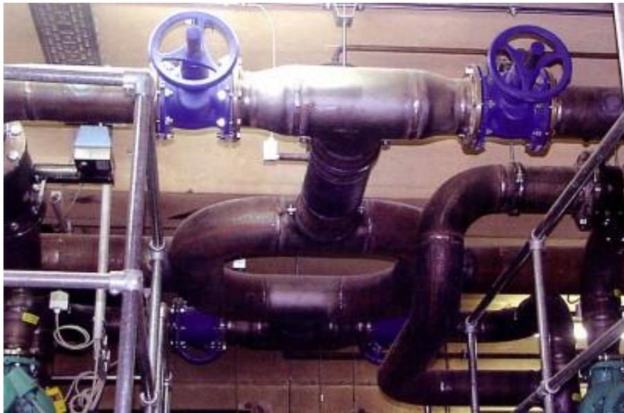
Obr. 6.21 – Paralelní zapojení kotlů přes hydraulický věnec [19]
