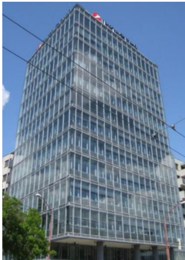
Obr. 2.2: Příklad existující budovy s dvojitým pláštěm [2]
