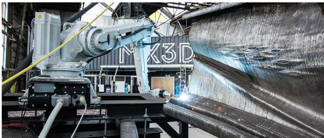
Obr. 28: Robot od firmy ABB navařující vrstvy mostu [22]
