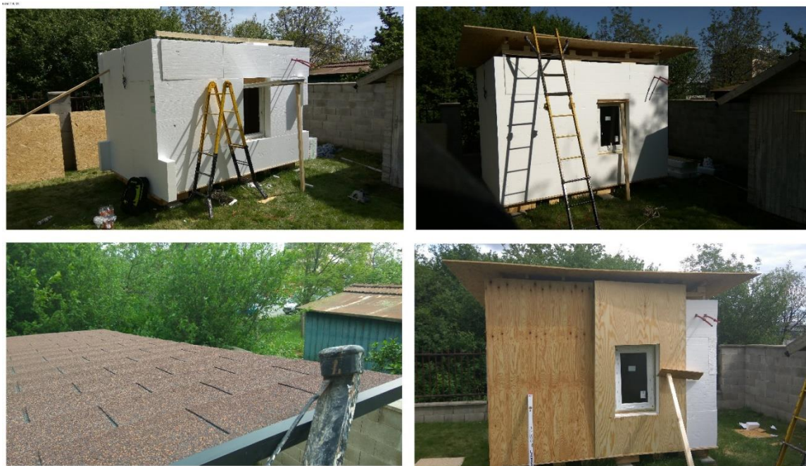
Obr. 4-5 Stavba střechy a vnějšího opláštění
