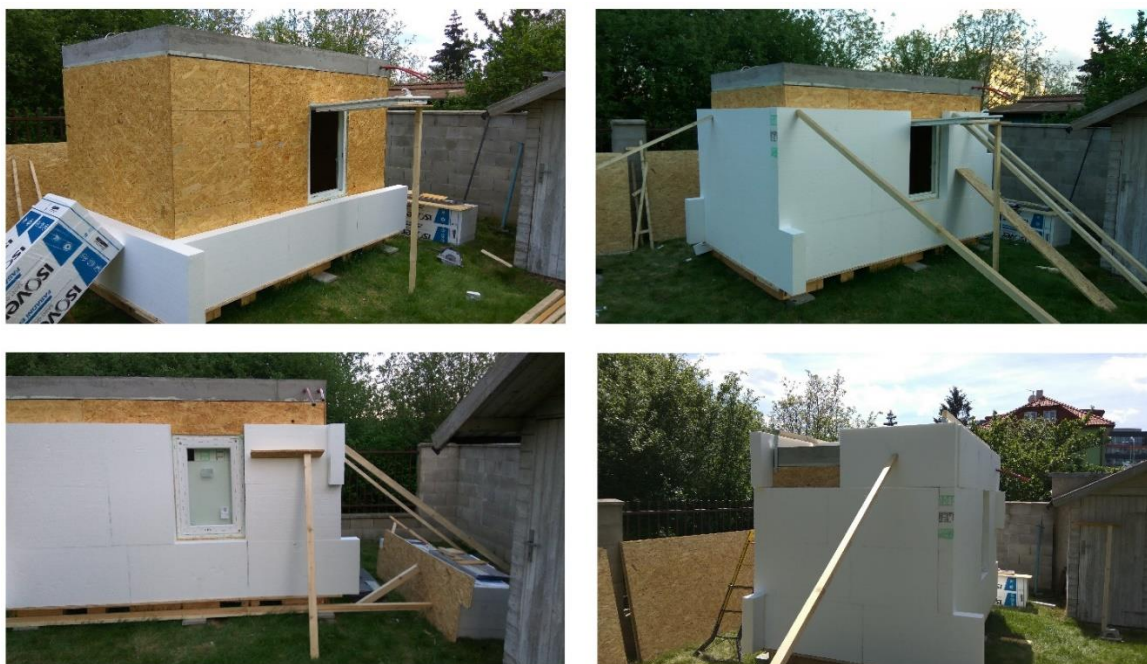
Obr. 4-4 Zateplení vnější obálky objektu mini TABS
