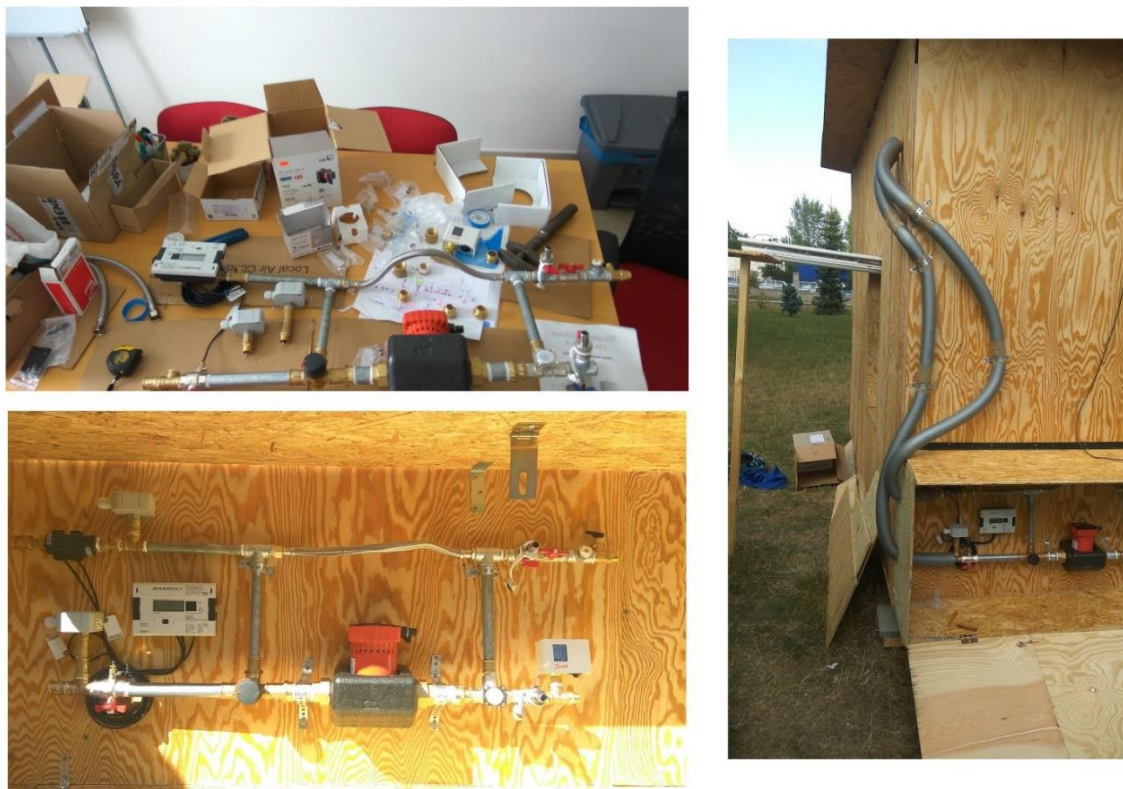
Obr. 4-6 Zapojení otopné soustavy
