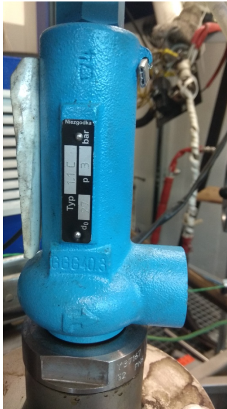
Obr. 20 Současný pojistný ventil
