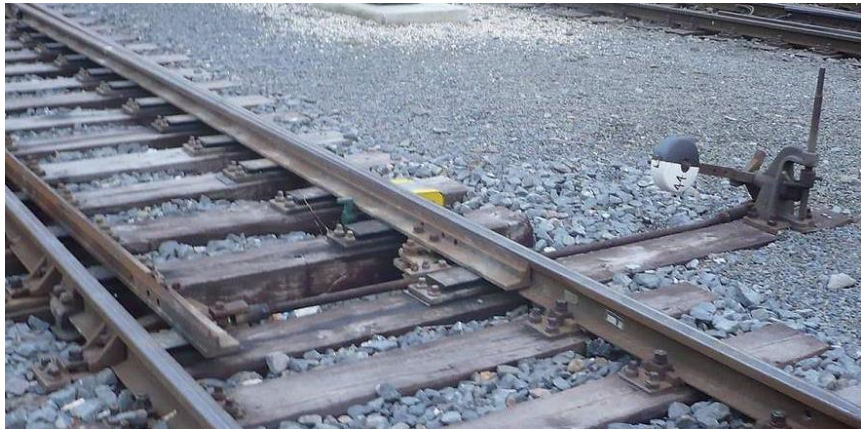
Obrázek 3. Mechanická výhybka [10]
