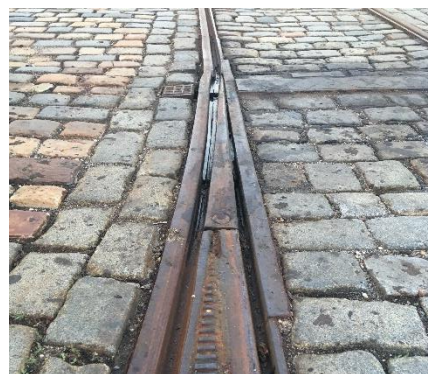
Obrázek 1. Jazyk s čepovým uložením
