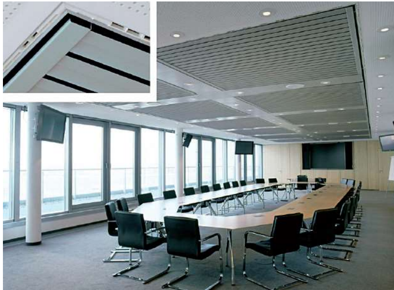
Obrázek 9.4 Integrace otevřeného chladícího stropu do sádrokartonového podhledu [10]
