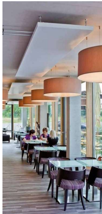
Obrázek 13.4 Umístění chladicího panelu – kontaktní systém
