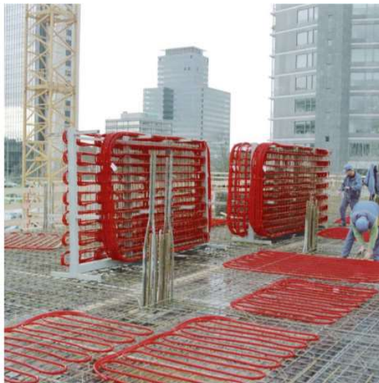
Obrázek 12.4 Uložení potrubí pro aktivaci betonu [13]
