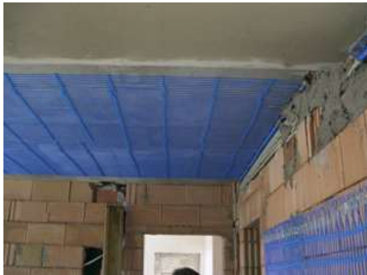
Obrázek 11.4 Uložení kapilárních rohoží pro chladící strop [25]
