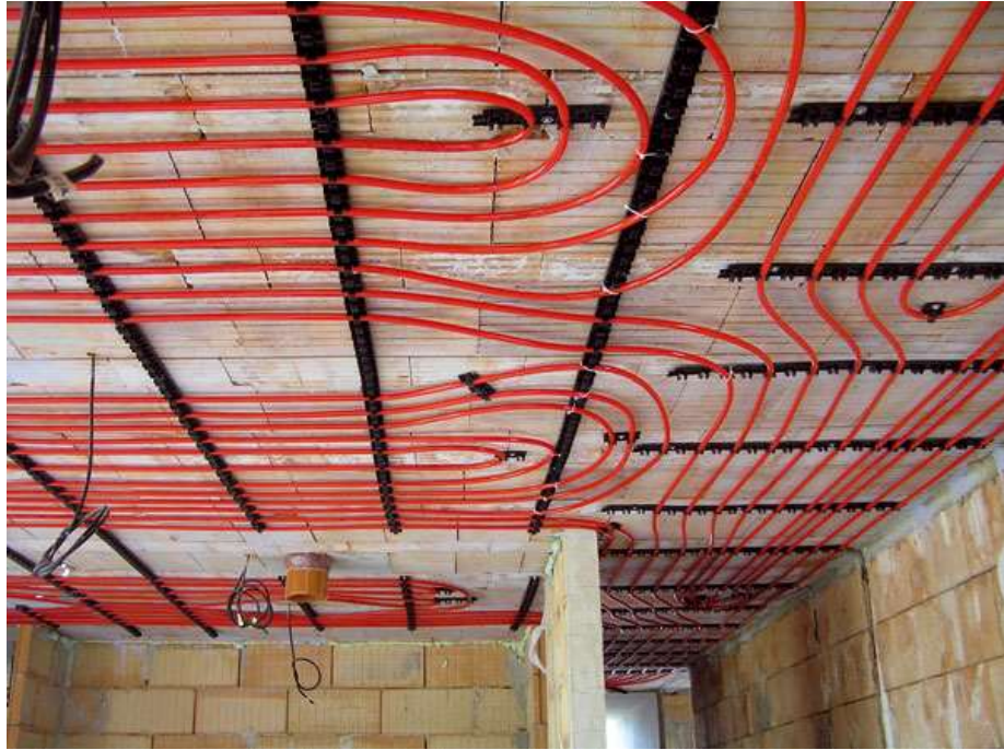
Obrázek 10.4 Rozvody trubkového chladícího stropu [11]
