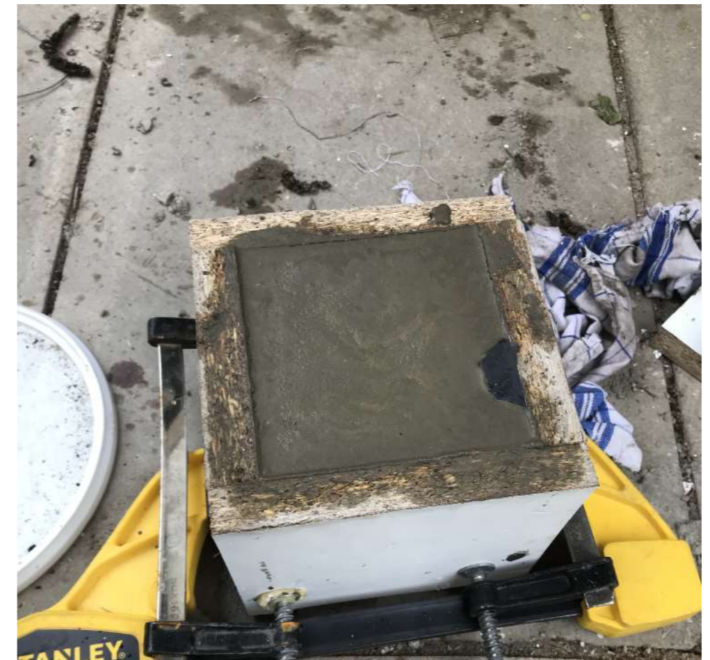
Do takto připravené formy jsem nalila rychletuhnoucí beton. Na horní straně jsem beton zarovnála dřívkem
