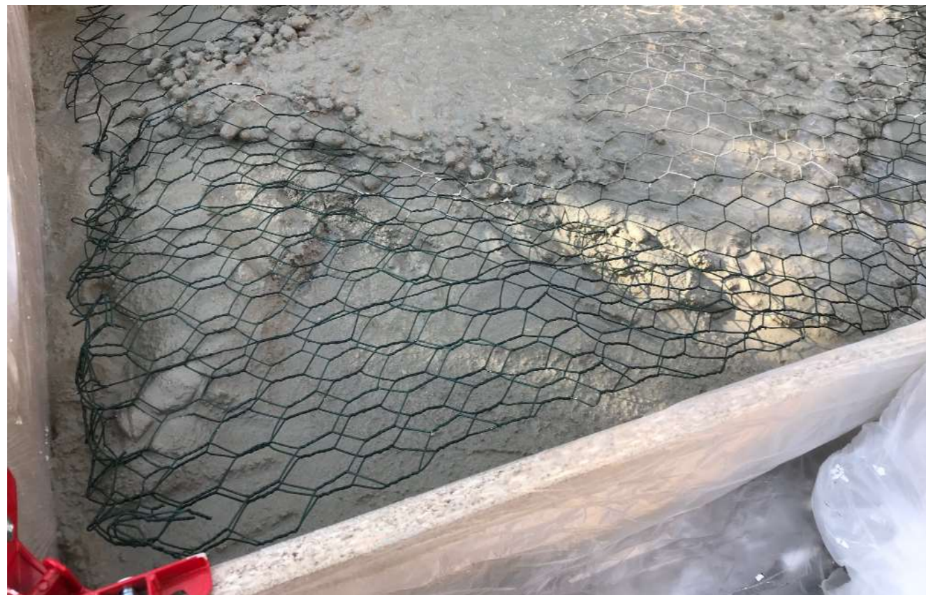
Zde je vidět aretace zaléváná směsí betonu a keramzitu.
