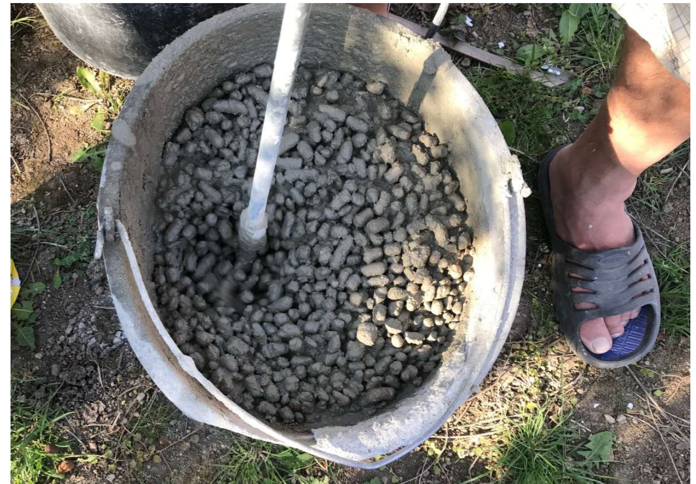
Do dalšího betonu jsme přimíchali elektrickým ručním míchačem keramzit pro odlehčení
