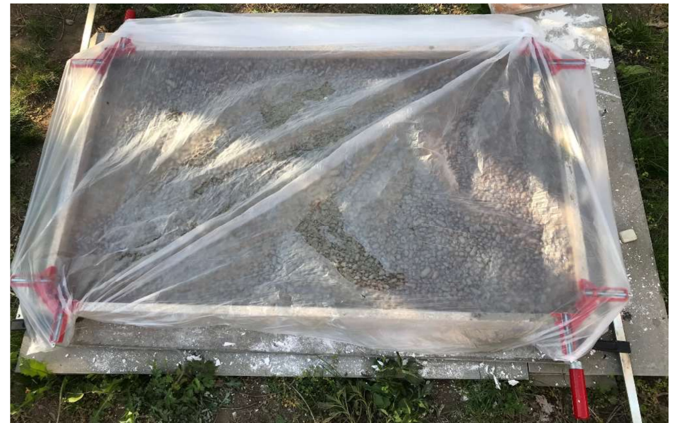
Nakonec jsem celou formu obalila igelitem, aby se zabránilo urychlenému vysychání betonu
