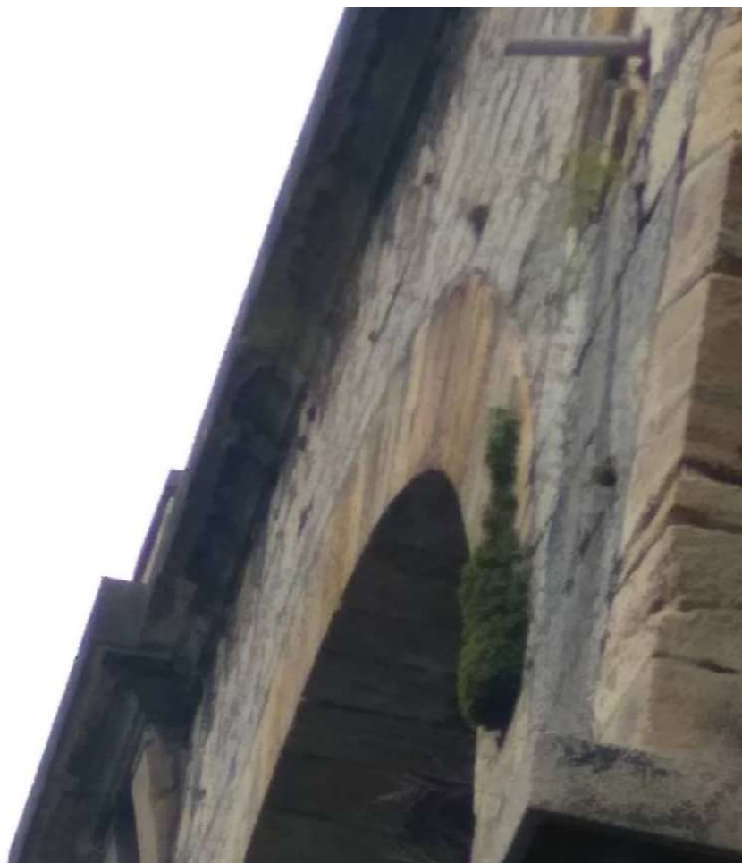
Hlubočepský viadukt Buštěhradská dráha
