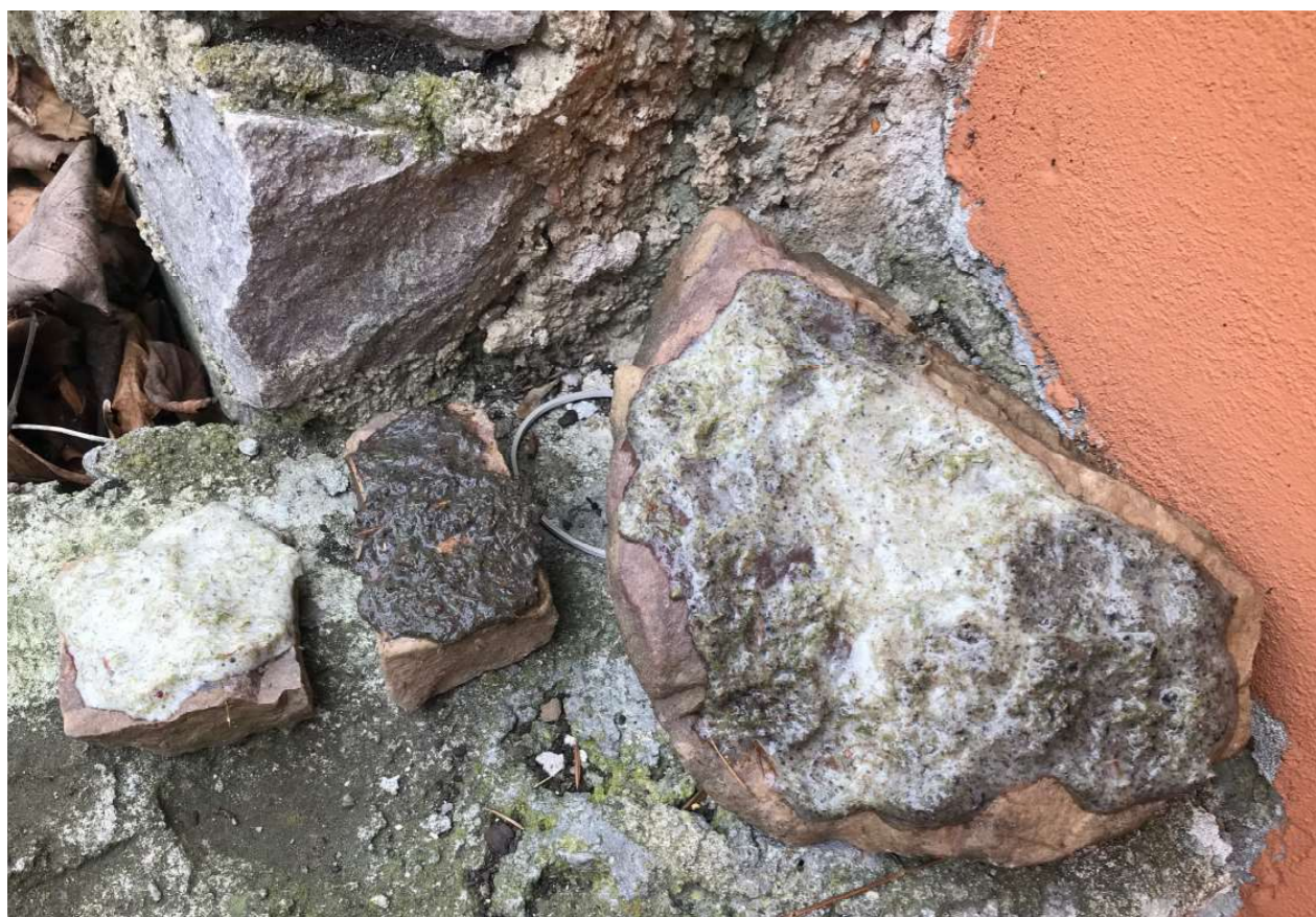
Aplikace směsi na přírodní kameny ve vytápěném interiéru (výše) a v exteriéru (niže).
