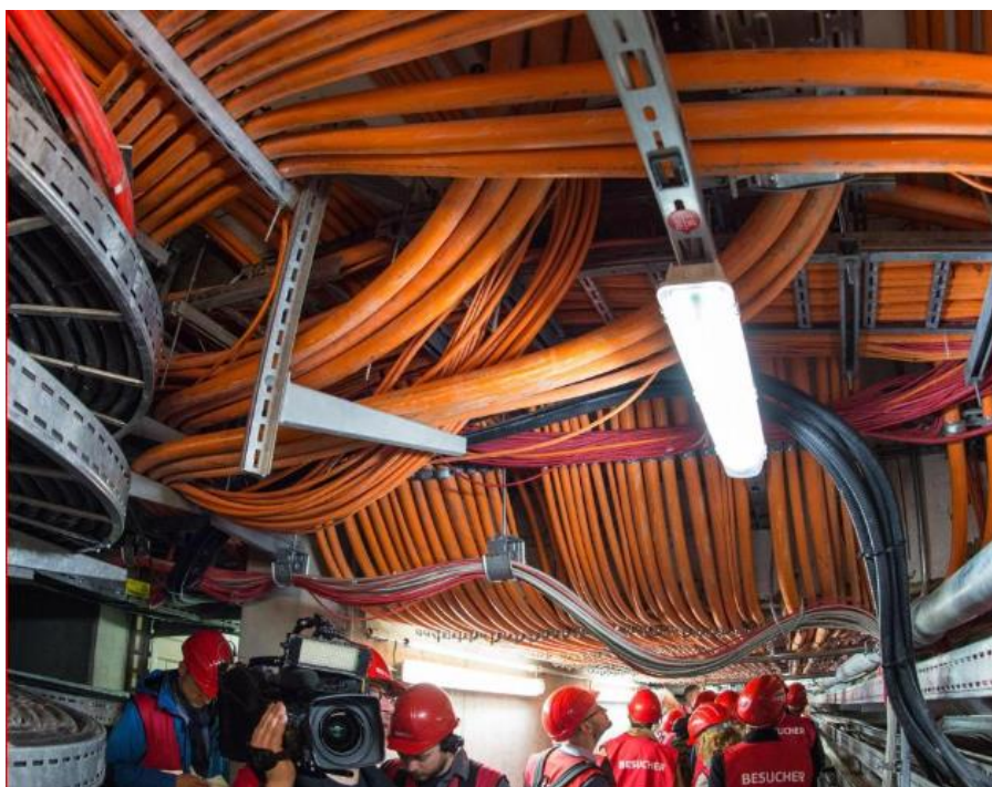
Obr. 23. Kabelový koridor pod hlavní budovou Terminálu [168].
