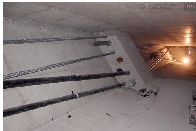
Obr. 10 Komorový nosník s vnější volnou předpínací výztuží [27]
