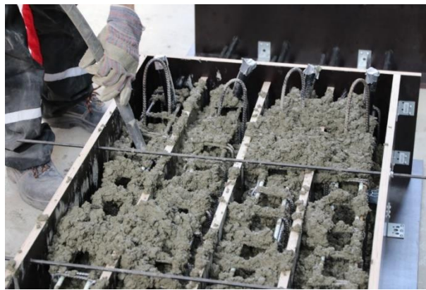
Obr. 52 Vibrování betonové směsi (foto: Martin Jonáš)
