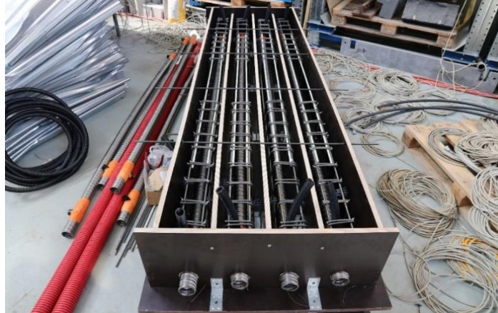
Obr. 51 Dokončené armokoše s chráničkami v bednění (foto: Martin Jonáš)
