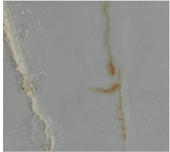
Obr. 124 Výluhy v místě předpínací výztuže (foto: Tomáš Dejmek)
