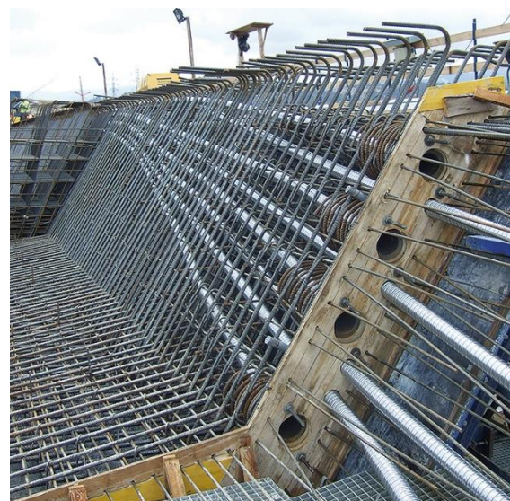
Obr. 8 Připravené chráničky pro předpínací výztuž [26]
