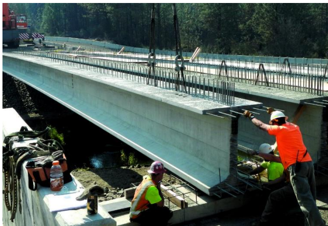
Obr. 4 Předem předpjaté mostní nosníky [23]
