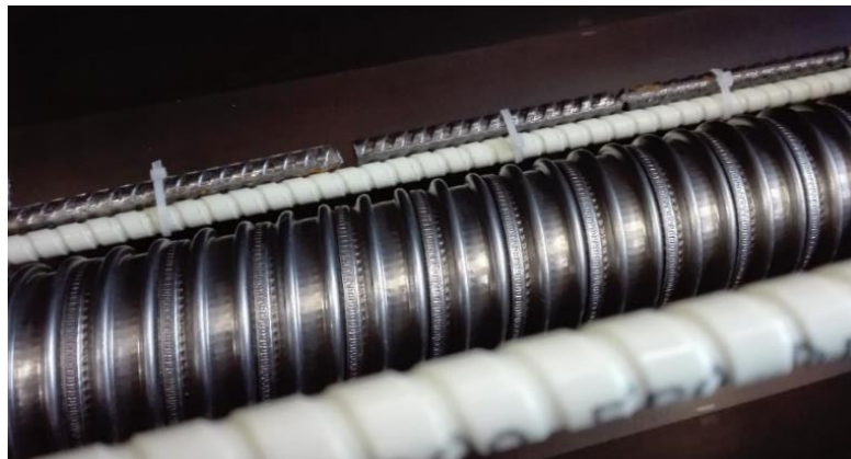
Obr. 50 Detail přidané kovové výztuže (foto: Martin Jonáš)
