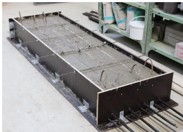
Obr. 53 Dokončená betonáž vzorků (foto: Martin Jonáš)
