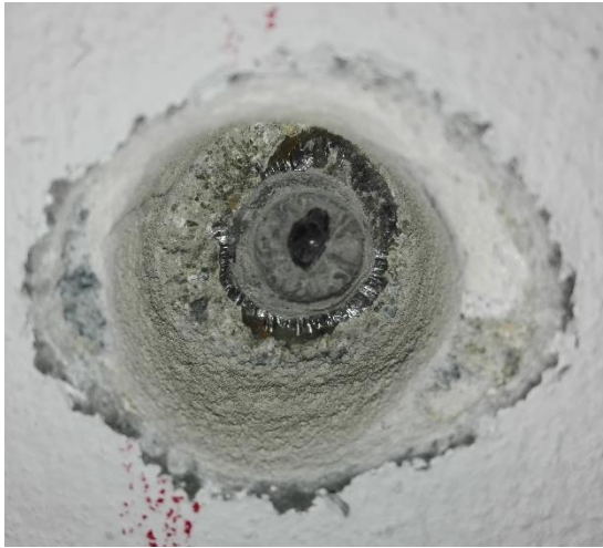
Obr. 123 Navrtaný kanálek předpínací výztuže (foto: Tomáš Dejmek)
