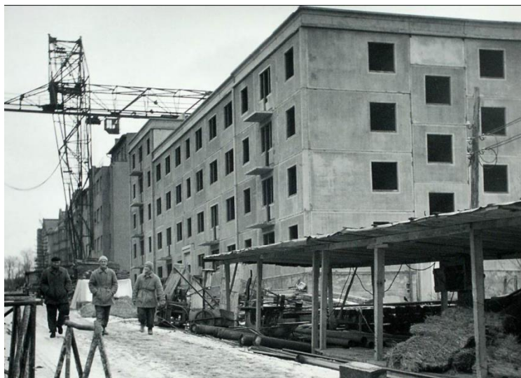
Obr. č. 2 Stavba prvního panelového domu v Brně
