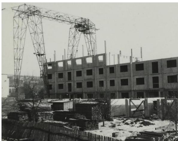
Obr. č. 4 Výstavba panelového domu G40 roku 1953-1954 ve Zlíně
